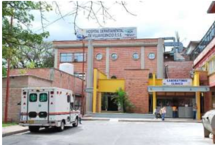
Figura 2 Fotografía del Hospital Departamental de Villavicencio
