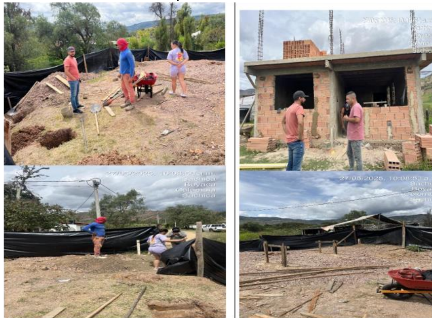
Figura 12. Incumplimiento de normatividad urbanística y ambiental: La fotografía muestra una vivienda en proceso de construcción
