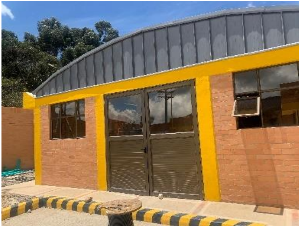
Imagen 12. Subestación Aquitania Fuente Autor
