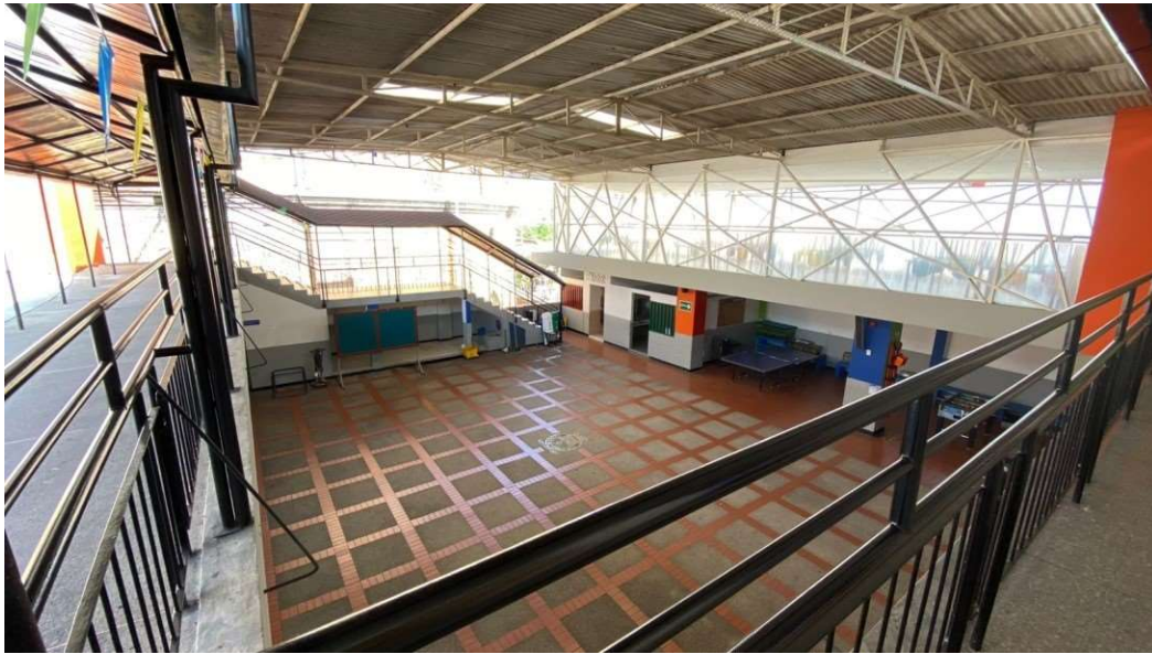
Figura 15. Segundo piso del Colegio
