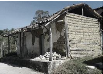
Casa en bahareque, san José de bolívar, Venezuela. Fuente: Guía de diseño para la vivienda de bahareque encementado
