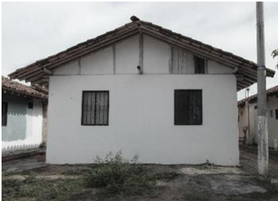
Bahareque encementado, Ricaurte valle de magdalena Colombia. Fuente: Guía de diseño para la vivienda de bahareque encementado.
