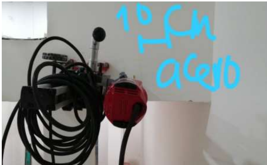
Ilustración 28 Ubicación del acero trasversal del elemento para la obtención de una muestra de concreto limpia. Fuente: Elaboración propia.
