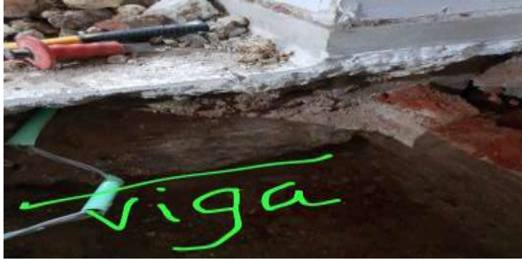
Ilustración 28 Viga de cimentación y sobrecimiento. Fuente: elaboración propia.
