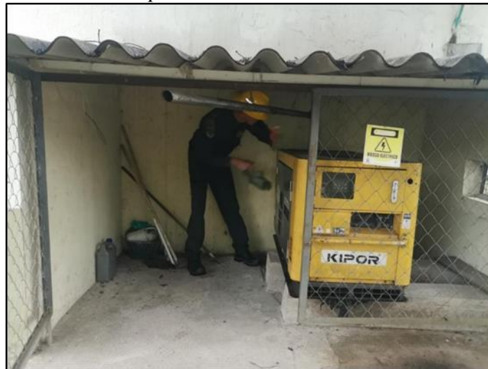
Figura 18. Trabajador movimiento repetitivo
