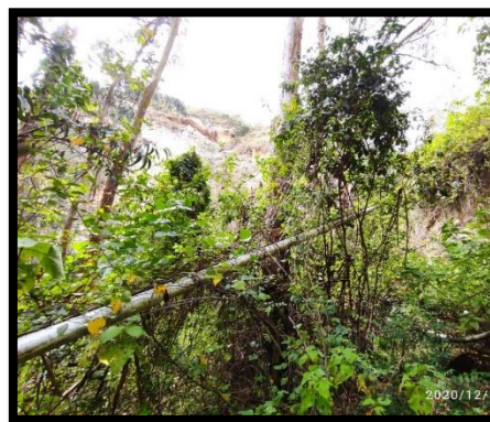
Ilustración 63: Línea de aducción Quebrada La Rosa Paso elevado N° 3
