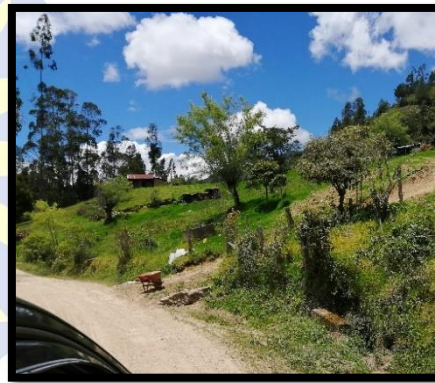
Ilustración 30: Reconocimiento del estado de vías rurales
