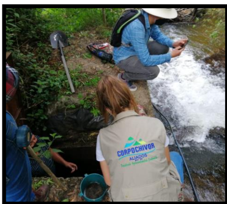
Ilustración 54: Línea de aducción Quebrada Única Bocatoma
