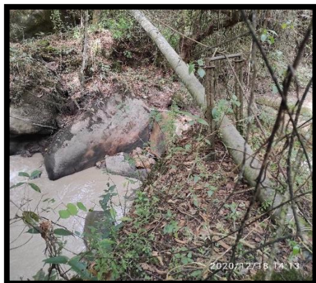
Ilustración 64: Línea de aducción Quebrada La Rosa Paso elevado N° 4
