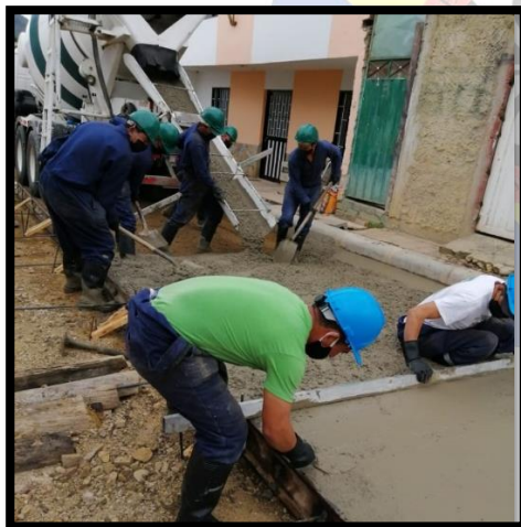
Ilustración 7: Visita Cra 1° Vibrado del concreto
