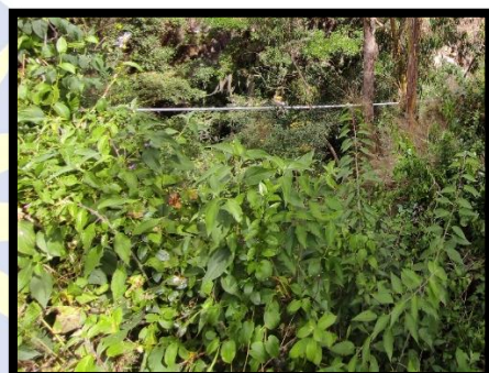
Ilustración 62: Línea de aducción Quebrada La Rosa Paso elevado N° 2
