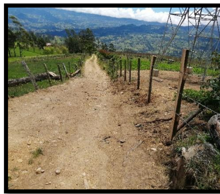
Ilustración 29: Reconocimiento del estado de vías rurales
