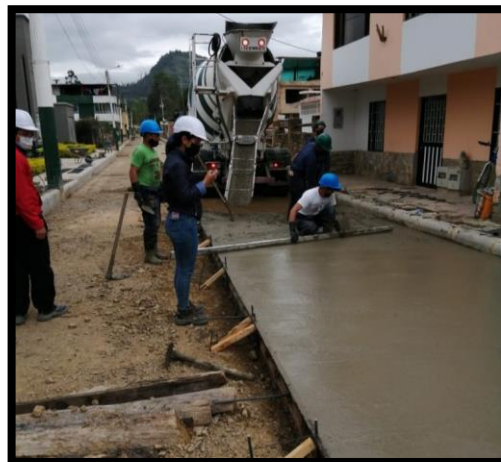
Ilustración 8: Visita Cra 1° Alisado del concreto
