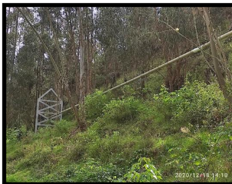
Ilustración 66: Línea de aducción Quebrada La Rosa Paso elevado N° 5
