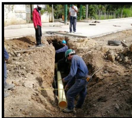
Ilustración 13: Visita Cra 1° Tubería para sumidero
