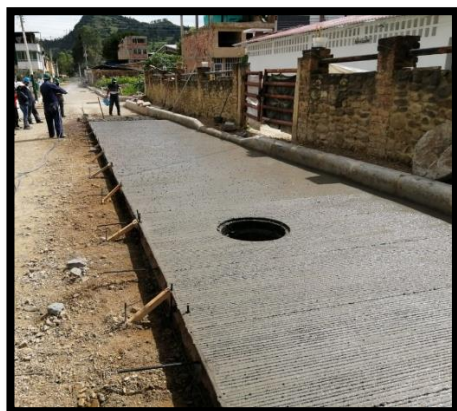
Ilustración 10: Visita Cra 1° Curado del concreto
