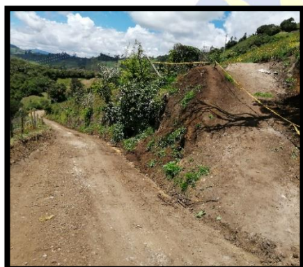
Ilustración 27: Reconocimiento del estado de vías rurales
