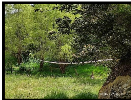
Ilustración 61: Línea de aducción Quebrada La Rosa Paso elevado N° 1
