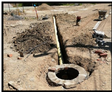
Ilustración 12: Visita Cra 1° Tubería para sumidero
