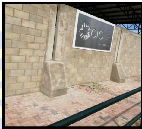
Ilustración 18: Visita C.I.C Construcción de pie de amigos
