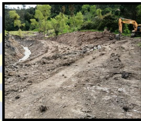
Ilustración 52: Acompañamiento a funcionaria de la gobernación en zona de deslizamiento
