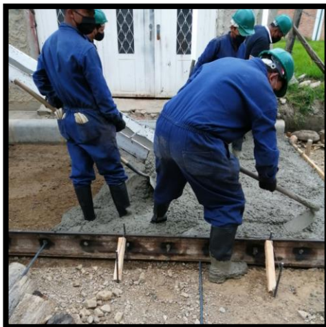
Ilustración 6: Visita Cra 1° Vaciado del concreto
