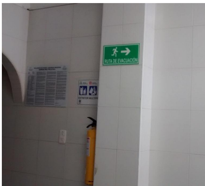
Figura 2. Instalación de Señalización de Emergencia
