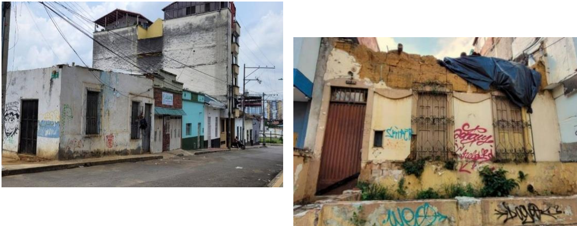
Figura 4. Inmuebles en abandono
