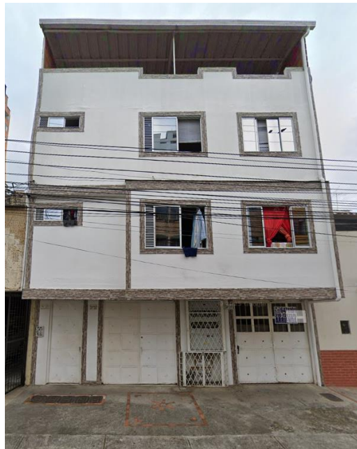
Figura 28. Fachada del edificio RR43 vivienda en arriendo de Marly Jerez
