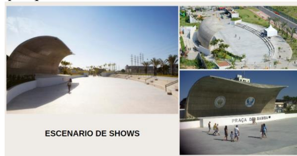
Figura 69. Fotografía del parque madureira 2
