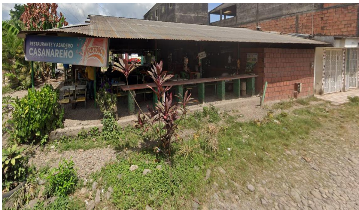
Figura 4. Vivienda y local comercial que no cuenta con confinamiento, por autores, 2025.
