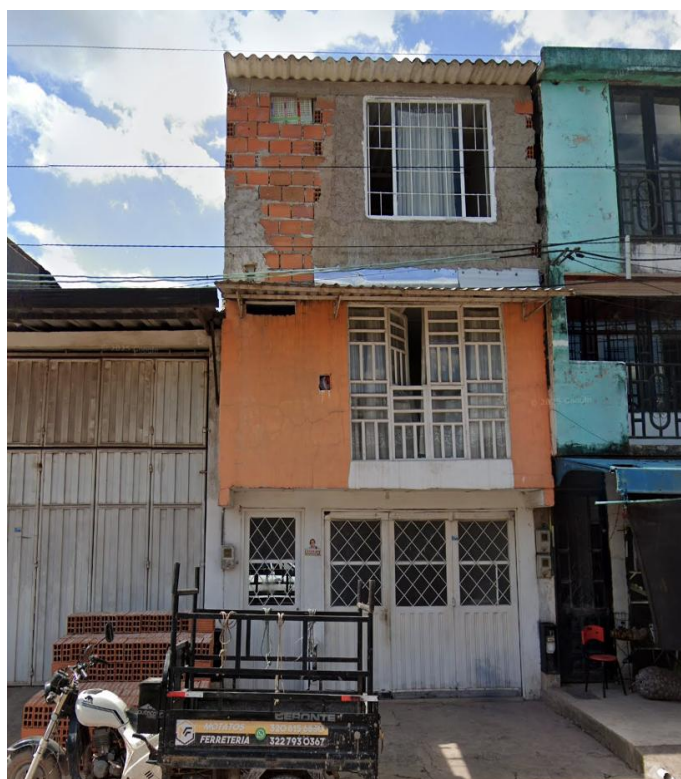
Figura 3. Vivienda de 3 niveles que no cuenta con confinamiento, por autores, 2026.
