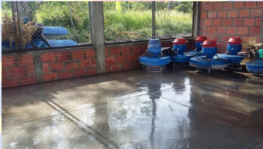
Figura 3. Limpieza y adecuación de área
