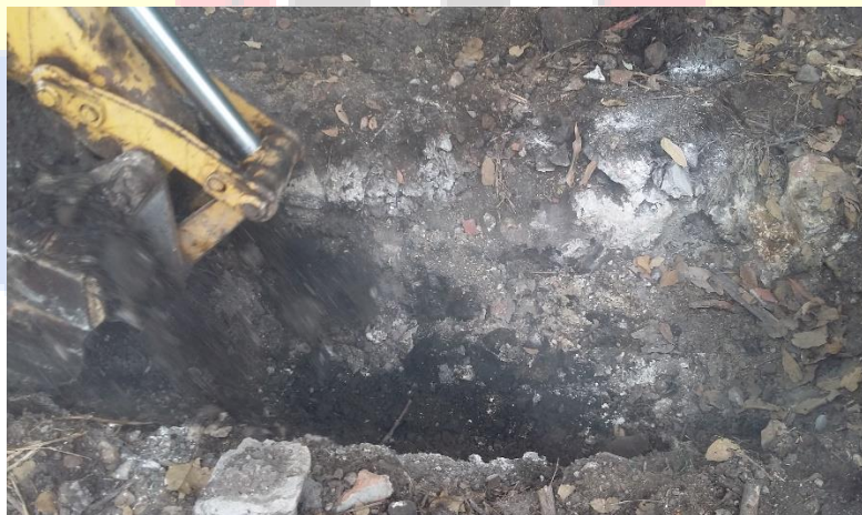
Figura 12. Agujero con material sólido resultado de la fermentación del residuo y cal
