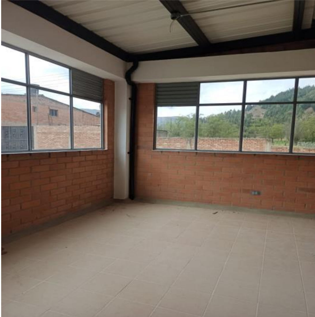
Ilustración 37. Pintura en vigas y columnas Centro de Desarrollo Infantil (CDI).
