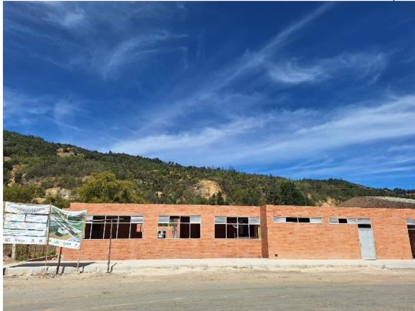
Ilustración 29. Visita de obra Centro de Desarrollo Infantil (CDI).
