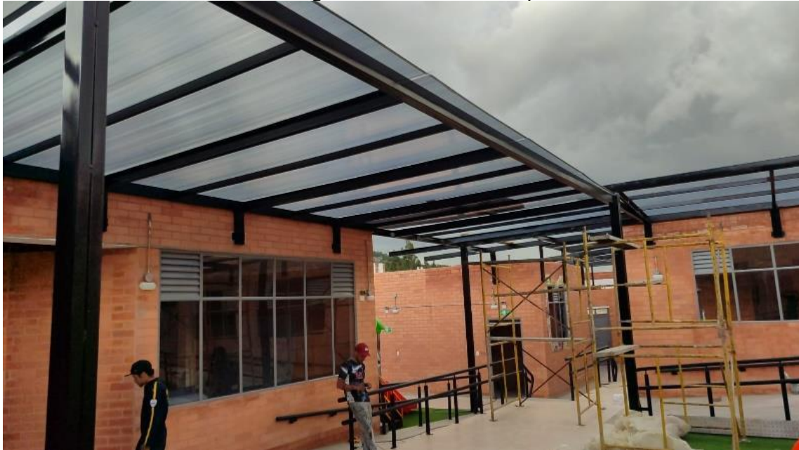
Ilustración 41. Seguimiento instalación policarbonato.
