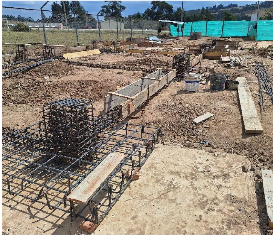
Ilustración 62. Encofrado cimentación
