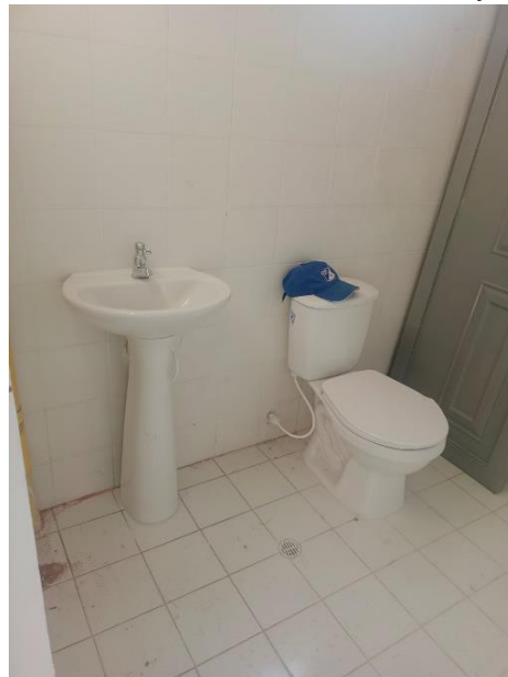
Ilustración 28. Instalación de sanitarios y cielo raso.
