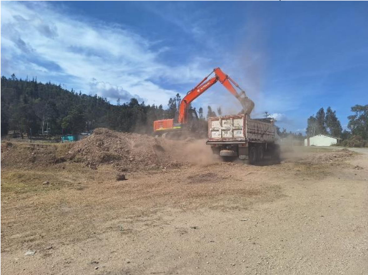
Ilustración 46. Movimiento de material villa olímpica.
