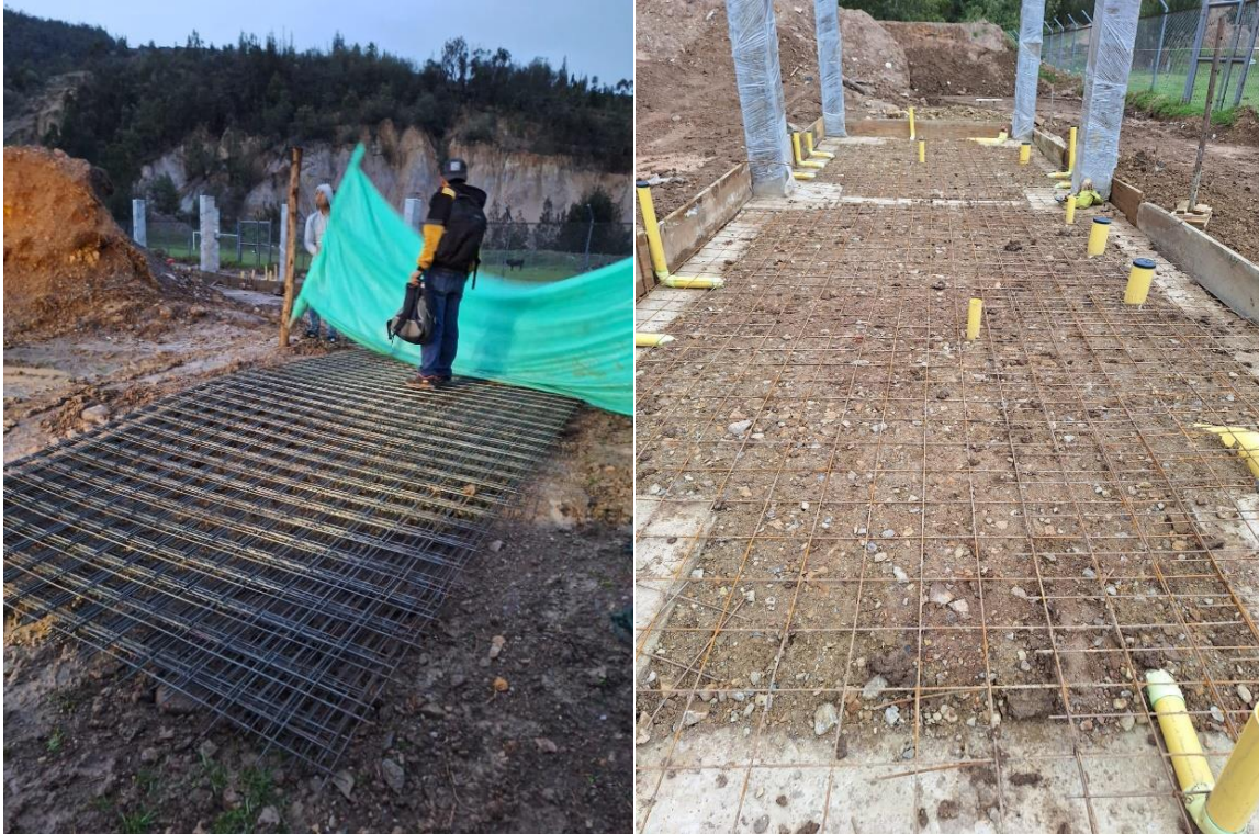
Ilustración 70. Recepción e instalación de insumos malla electrosoldada.
