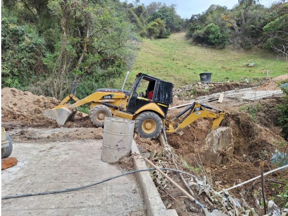
Ilustración 18. Excavaciones mecánicas puente placa huella corazón.
