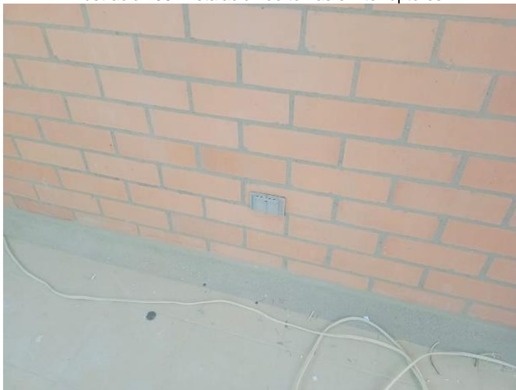
Ilustración 30. Instalación de tomas e interruptores.
