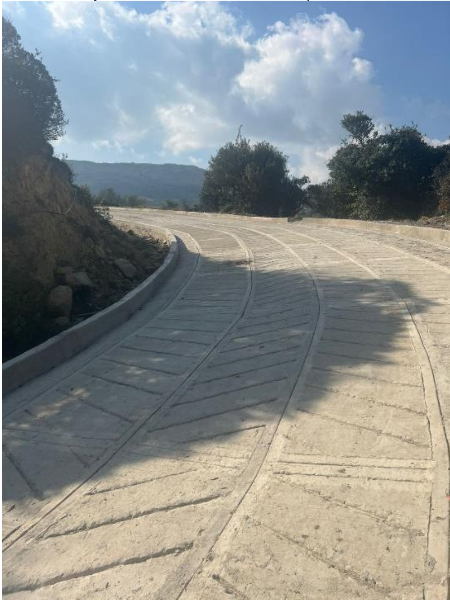
Ilustración 13. Control y verificación avance de obra placas huella vereda Corazón.
