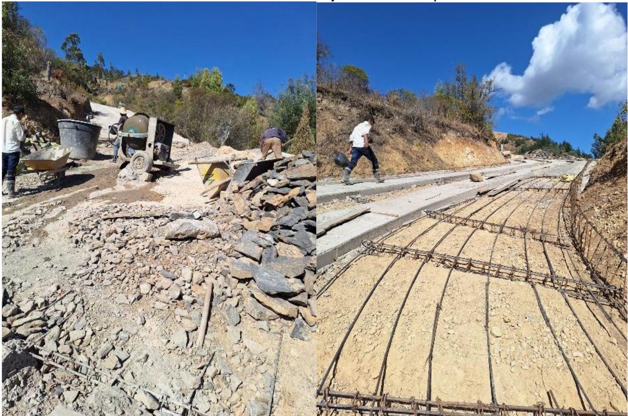
Ilustración 3. Visitas de control ejecución obra placas huella.
