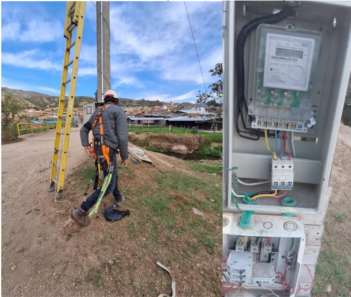
Ilustración 68. Instalación puntos eléctricos villa olímpica
