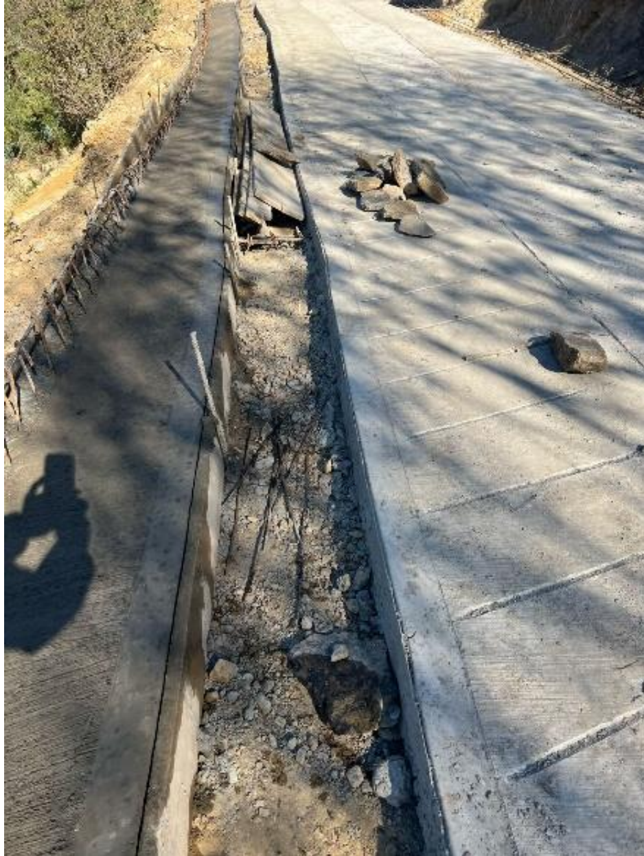
Ilustración 15. Avance fundido cuneta placa huella vereda Comunidad.
