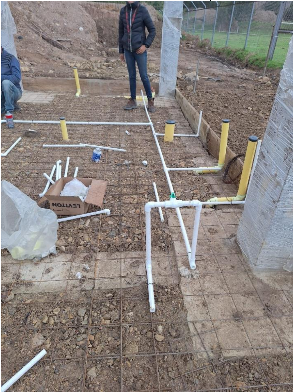
Ilustración 71. Instalación de tubería presión
