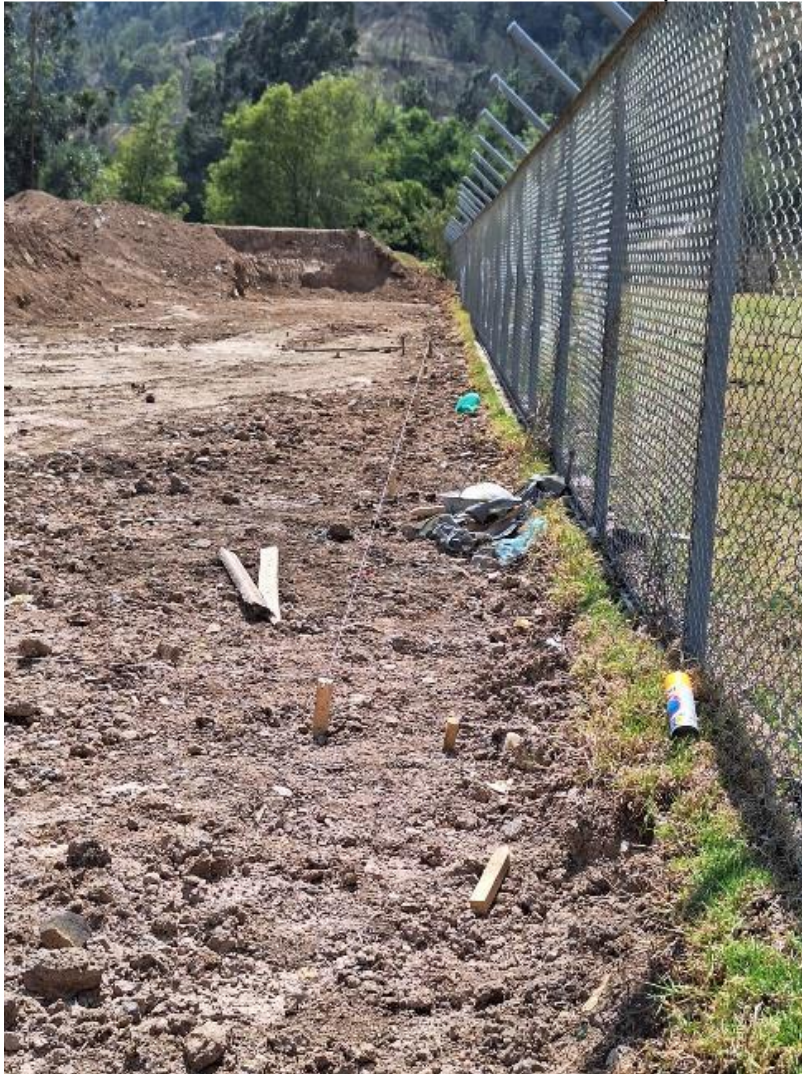
Ilustración 51. Trazado de línea de cordel replanteo.
