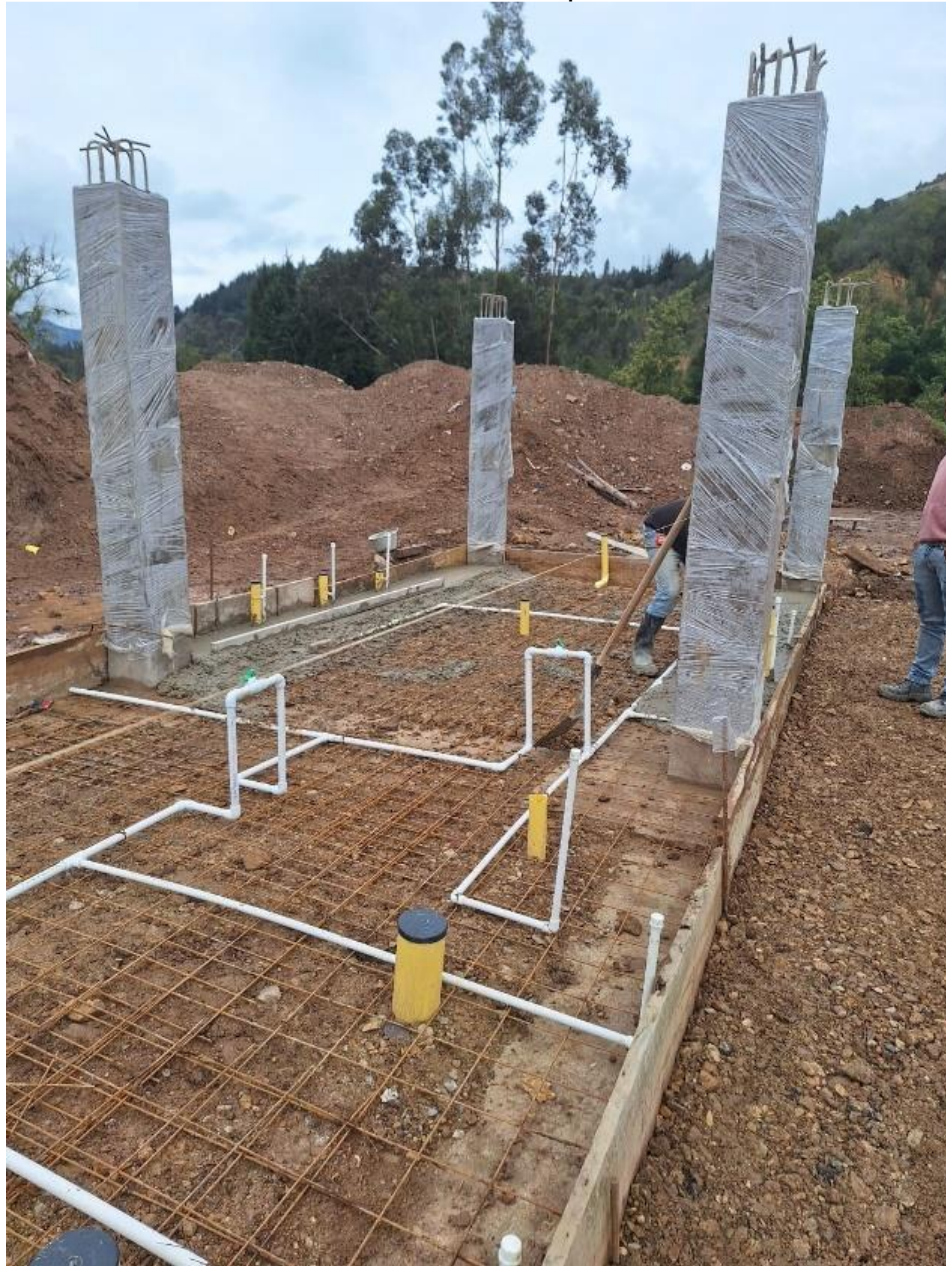
Ilustración 72. Fundido de placa E:10 cm
