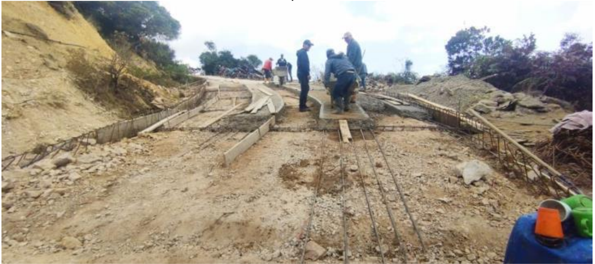
Ilustración 11. Avance de obra placas huella vereda Comunidad
