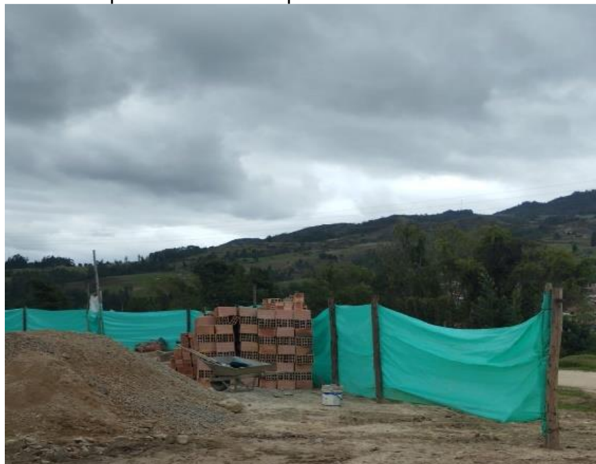
Ilustración 73. Recepción de insumos para continuación de actividades en obra.
