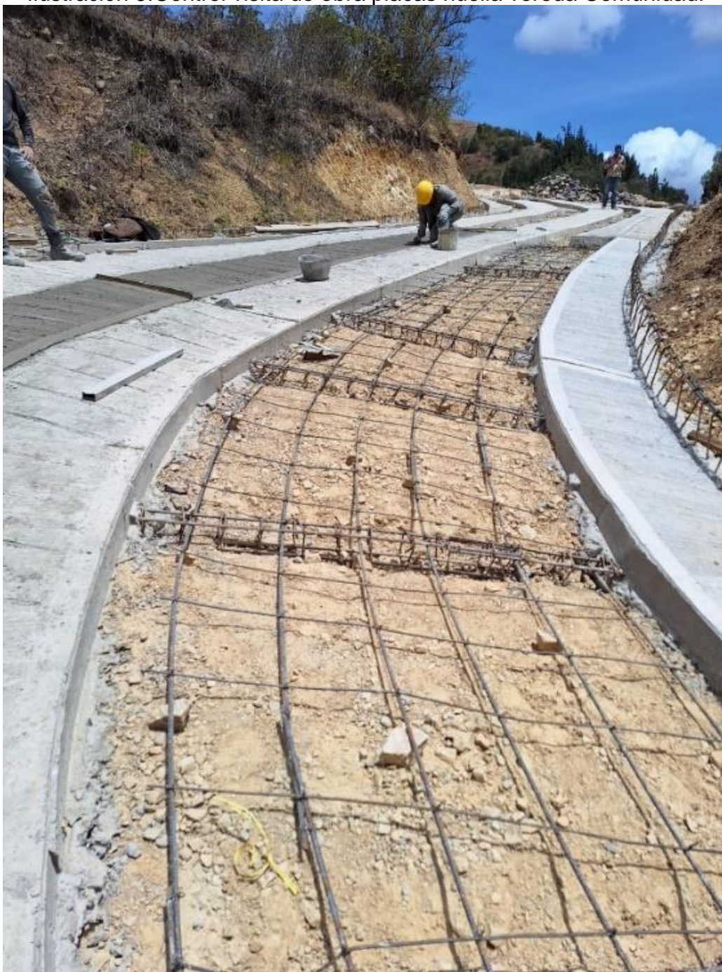
Ilustración 9. Control visita de obra placas huella vereda Comunidad.
