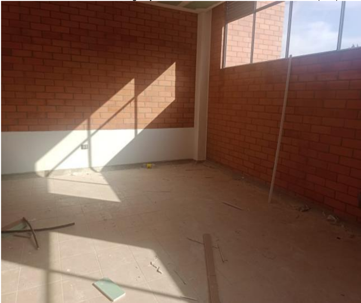
Ilustración 36. Pintura en vigas y columnas Centro de Desarrollo Infantil (CDI).
