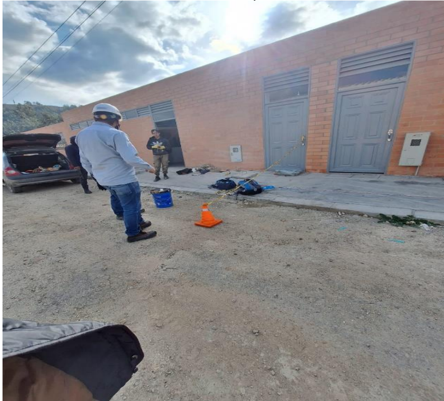
Ilustración 38. Evidencia reporte de acabados.
