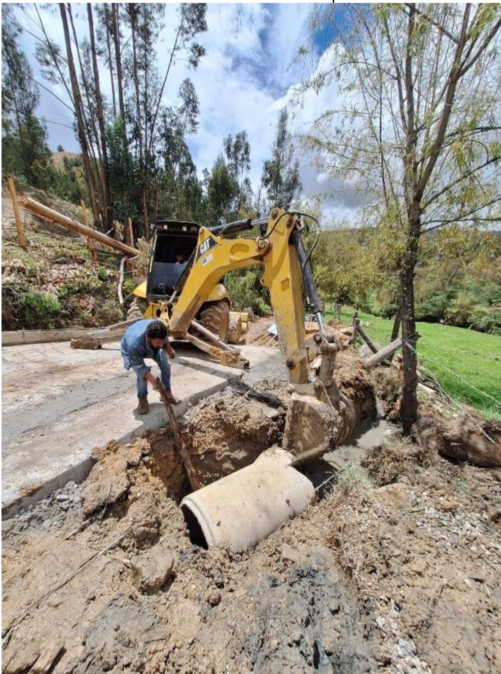
Ilustración 20. Instalación tubería de concreto placa huella comunidad.
