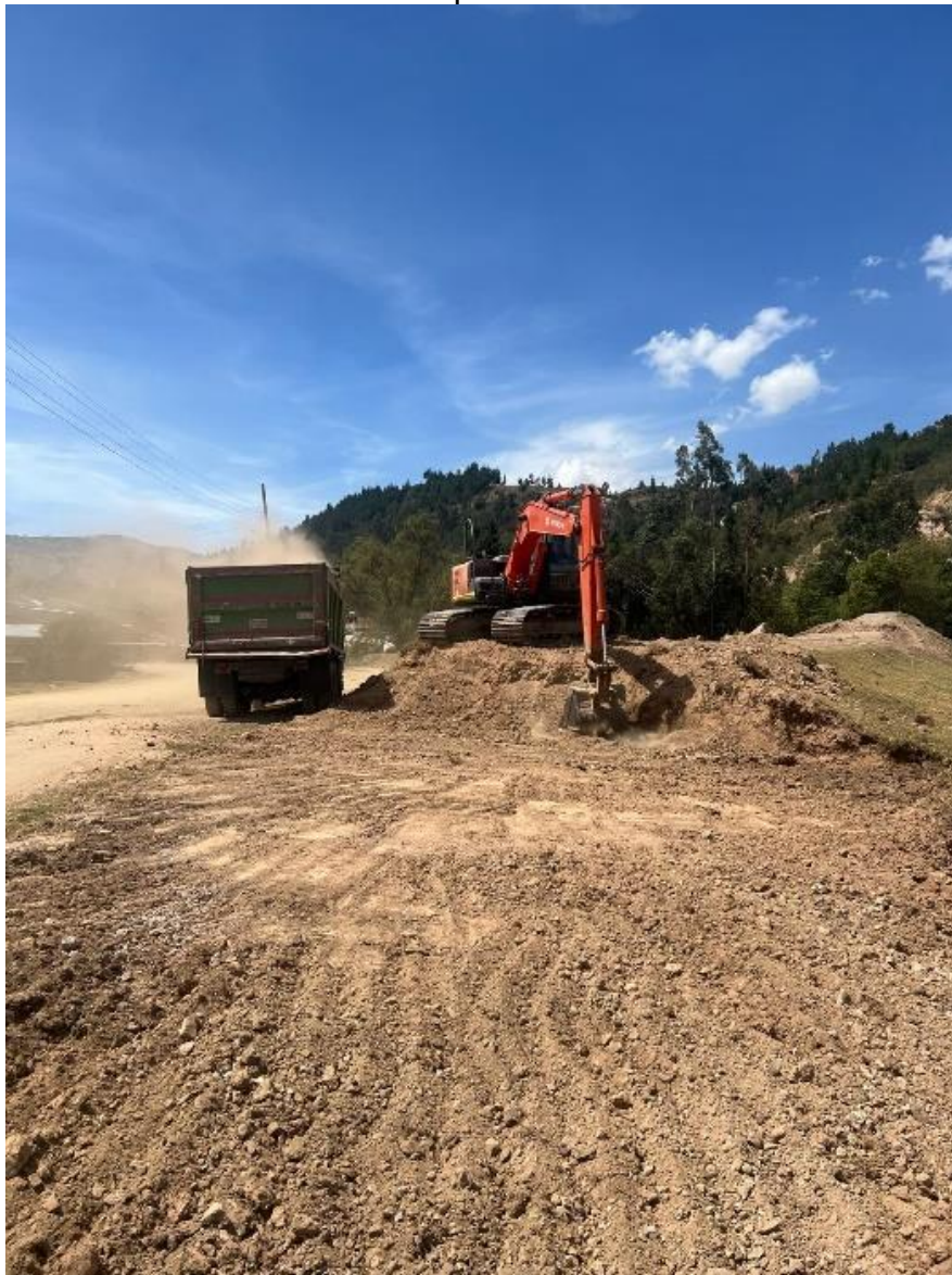
Ilustración 45. Inspección terreno obra.
