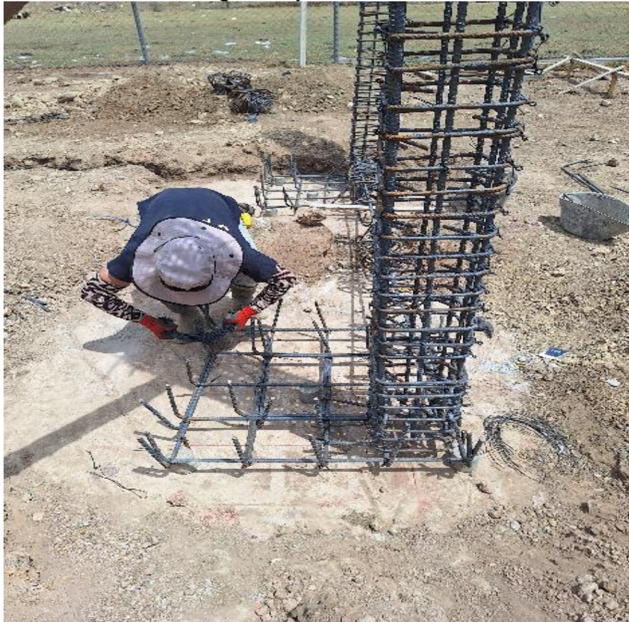
Ilustración 61. Suministro figurada y amarre de acero 60000 PSI 420 Mpa.
