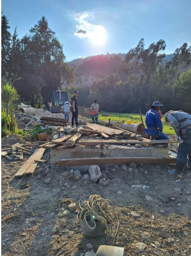
Ilustración 52. Desmote estructura cercha, parales y camilla.
