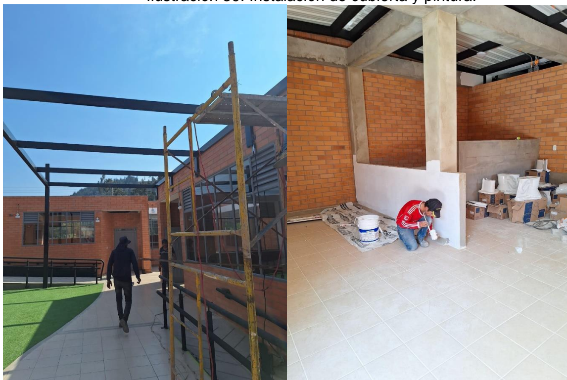
Ilustración 39. Instalación de cubierta y pintura.
