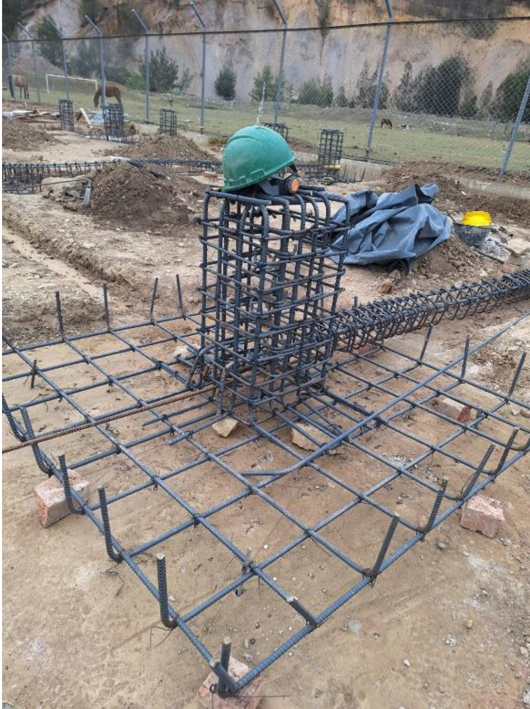
Ilustración 59. Suministro y figurado acero.
