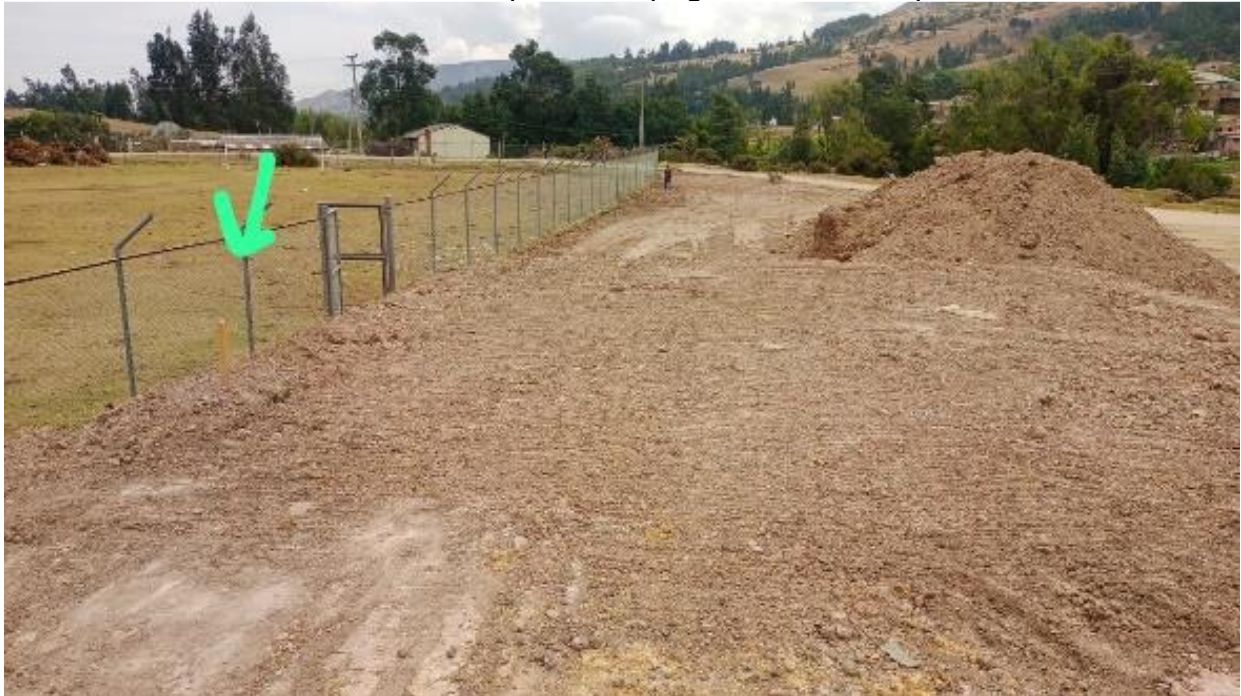
Ilustración 47. Replanteo topográfico villa olímpica.
