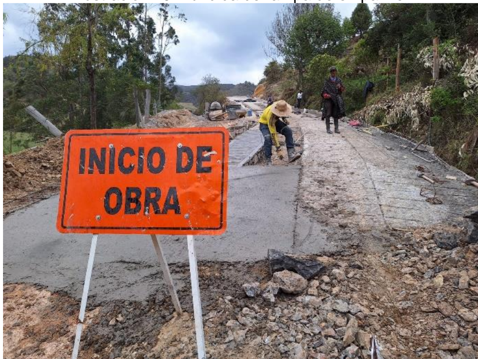
Ilustración 19. Fundida de rampa de empalme.
