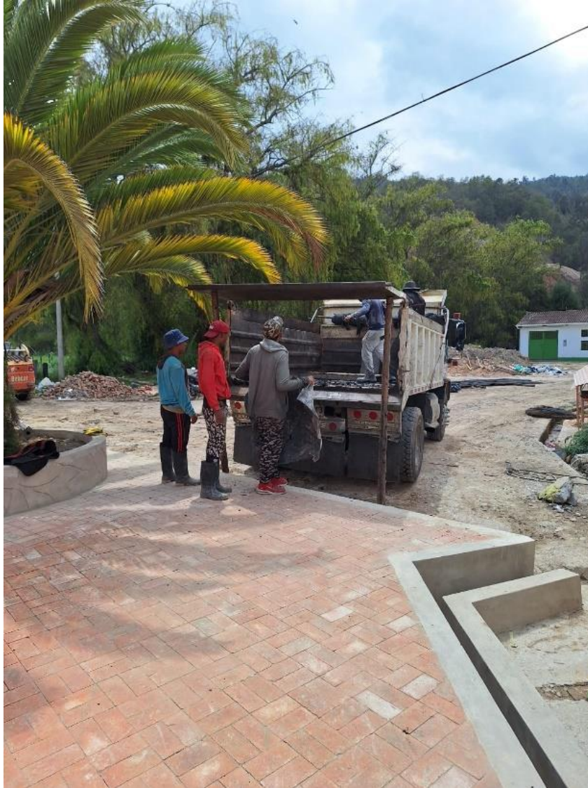
Ilustración 14. Programación y cargue de insumos (cemento) para obra placa huella.
