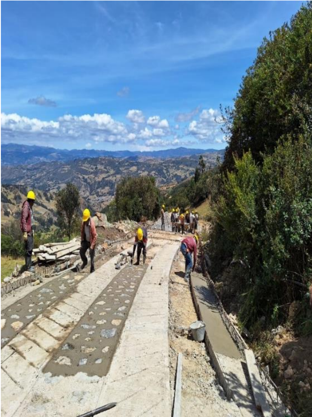
Ilustración 10. Control visita de obra vereda corazón.
