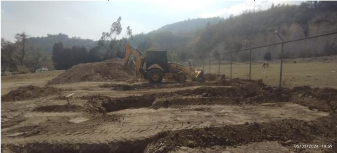
Ilustración 53. Supervisión excavaciones mecánicas y manuales.
