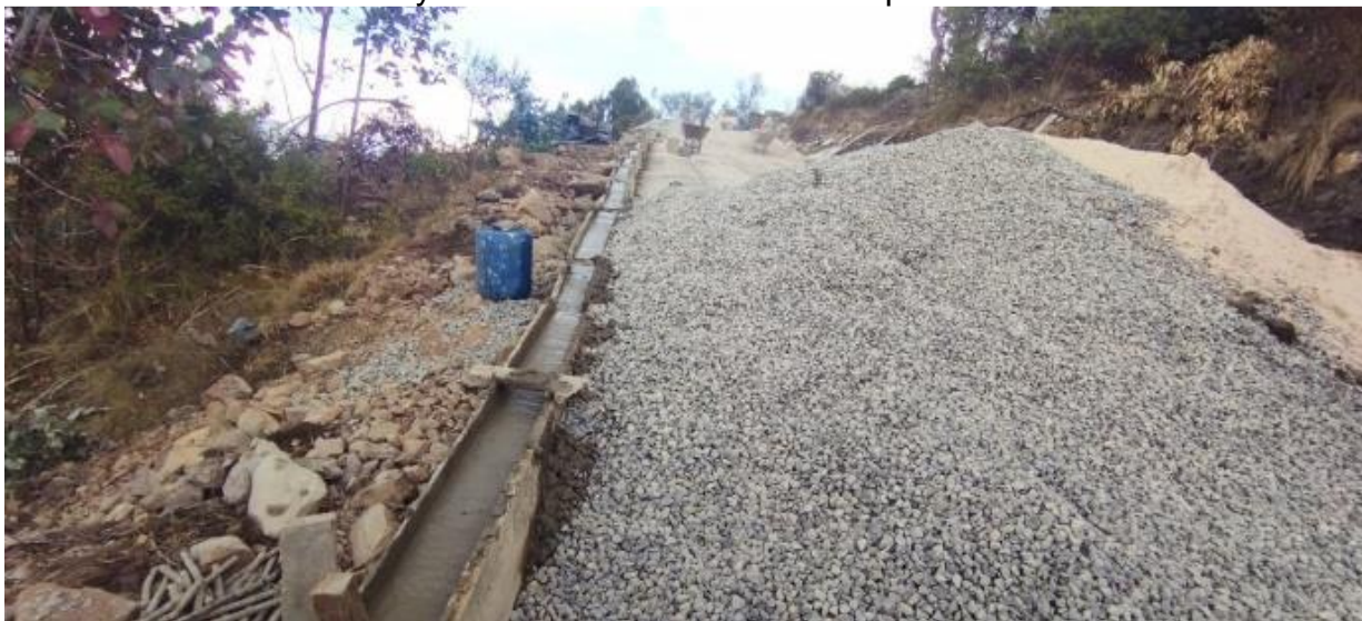
Ilustración 12. Control y verificación avance de obra placas huella vereda Tintal.
