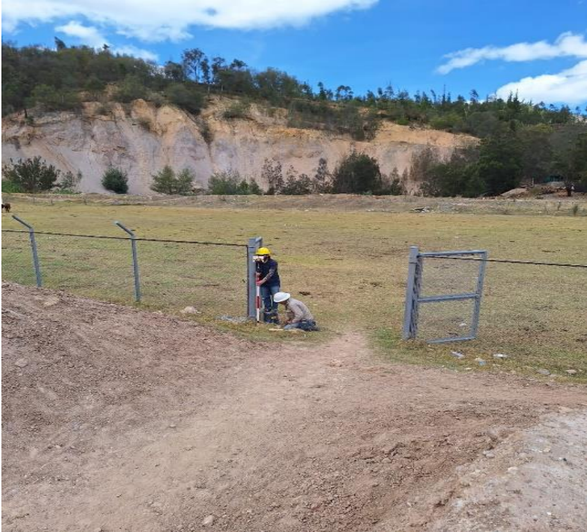
Ilustración 44. Visita localización de proyecto para replanteo topográfico.
