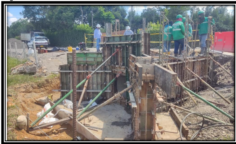
Figura 4 Construcción alcantarilla 1 tramo 3 vía Mercedes- Barcelona.
