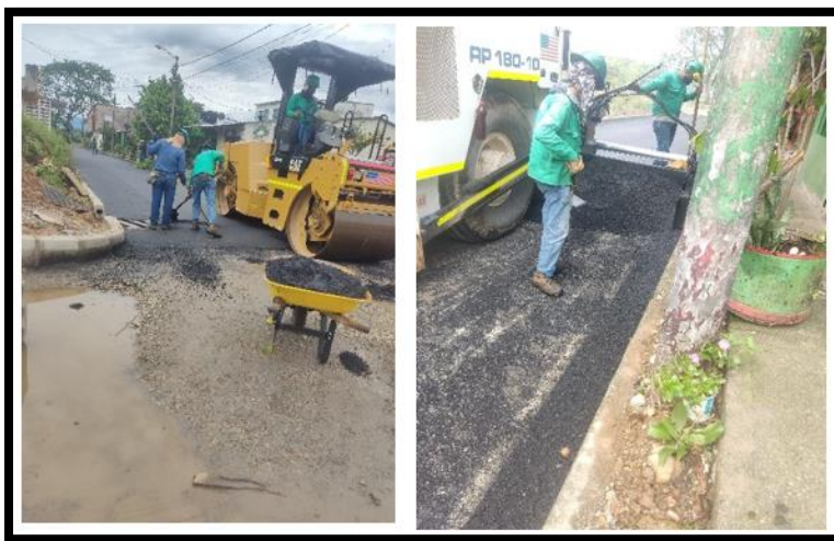
Figura 15 Extendido de mezcla asfáltica.
