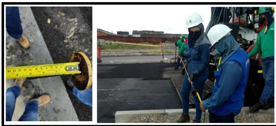
Figura 17 Control del espesor de la capa de mezcla asfáltica.
