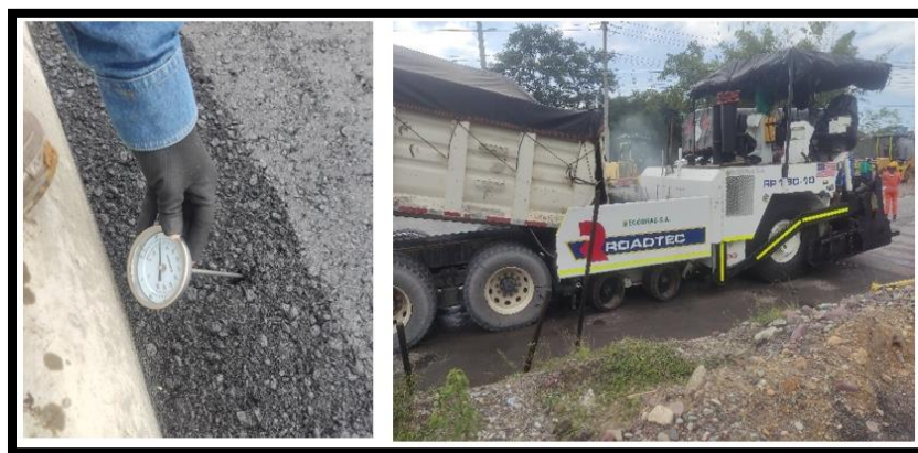
Figura 16 Control de temperatura en obra.
