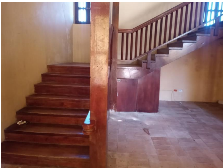
Imagen propia – Acceso Escalera en madera
