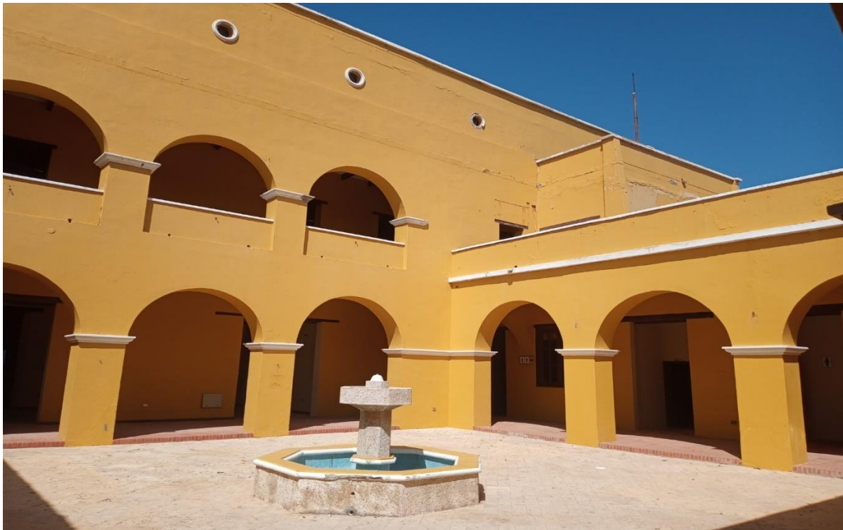
Imagen Propia – Vista Nororiental del patio interior de la Edificación.
