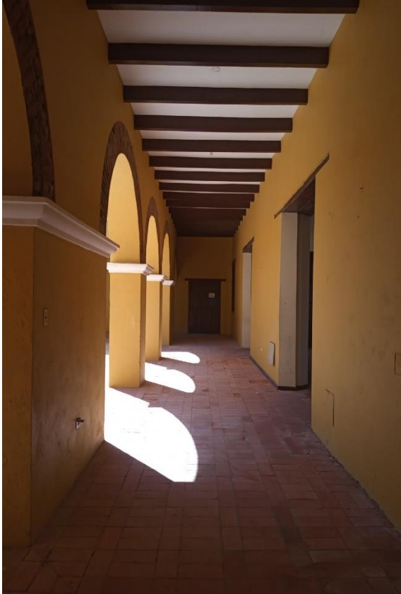
Imagen propia – Pasillo Norte
