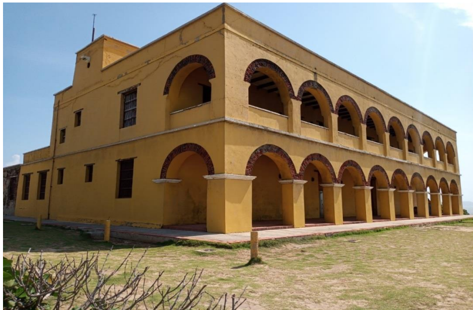
Figura 23. Vista de fachada Norteste
