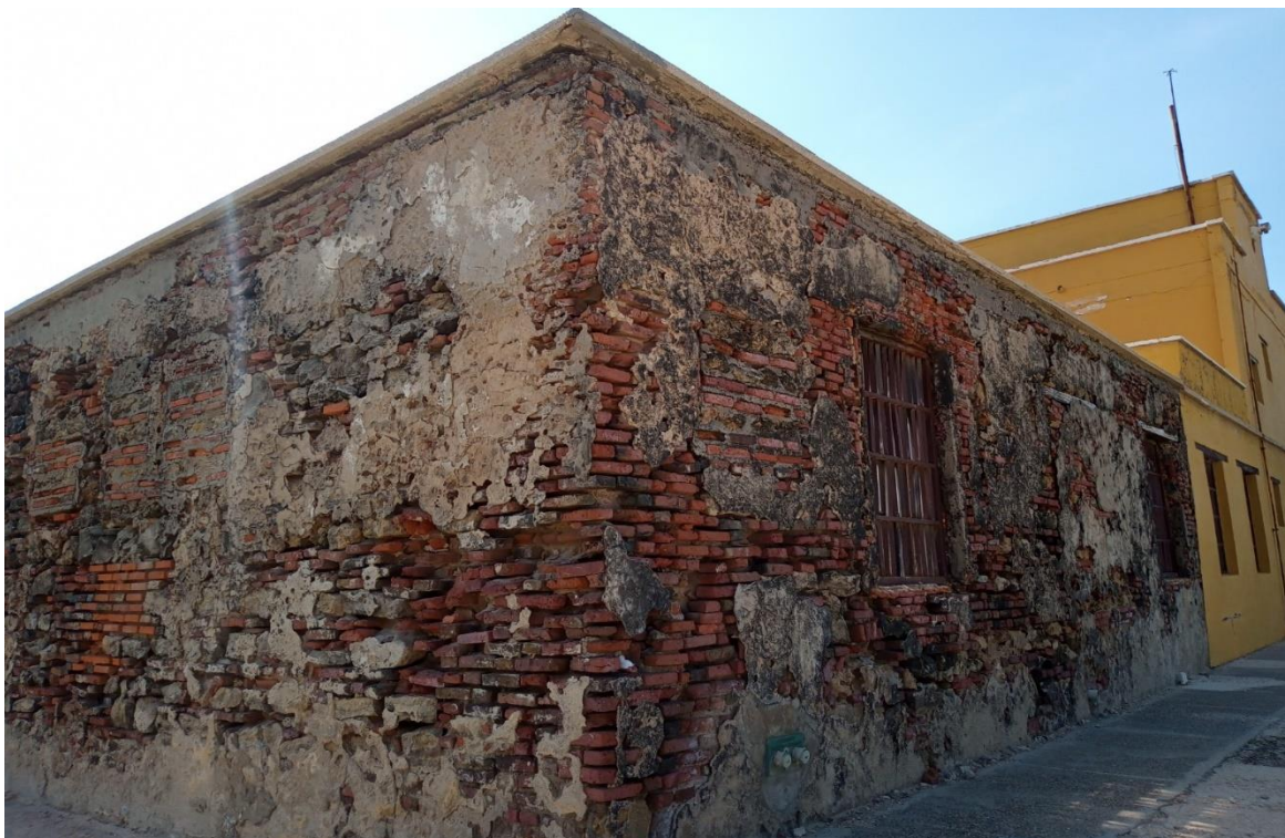
Imagen Propia - Esta fotografía nos indica el sistema constructivo primario de la edificación.
