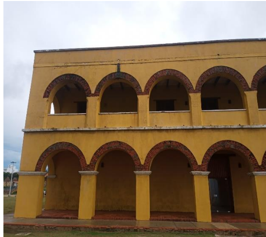
FOTOS-8 PISO FACHADA ACCESO NORTE
