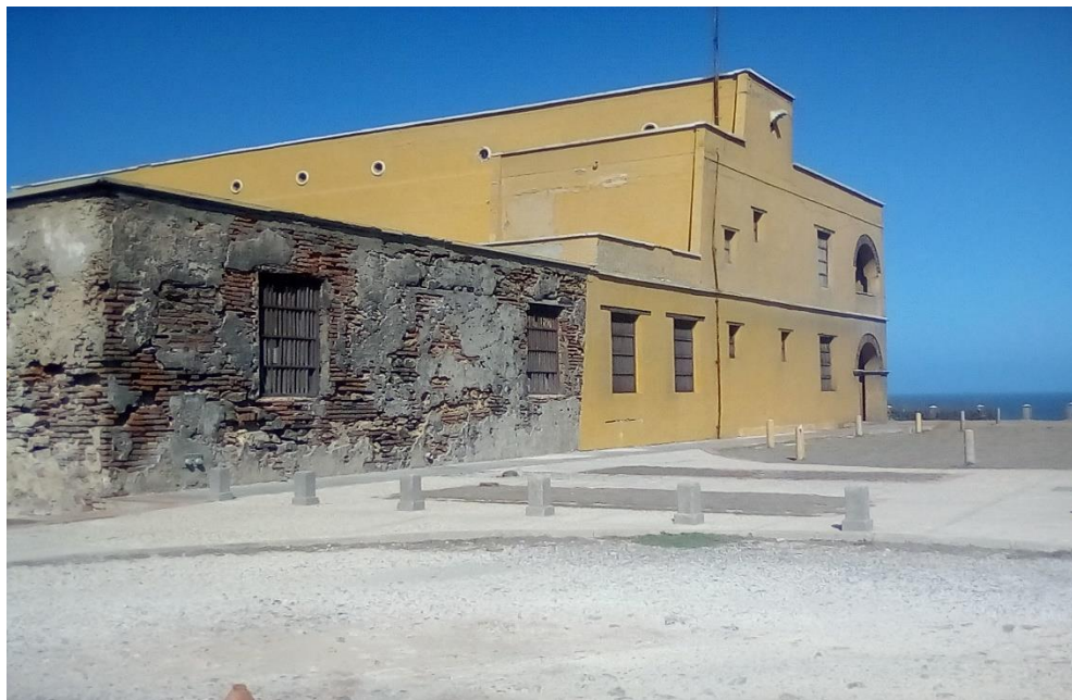
Figura 2, Detalle de la estructura parte lateral del castillo de Salgar
