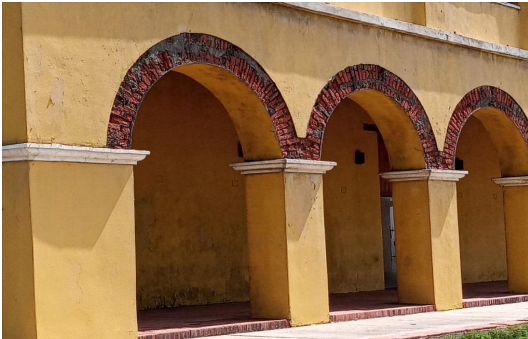
Figura 22. Vista de fachada Norte
