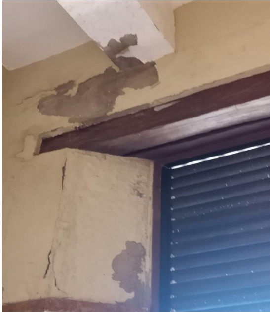
Imagen Propia – lesiones interiores por filtraciones de humedad en muros
