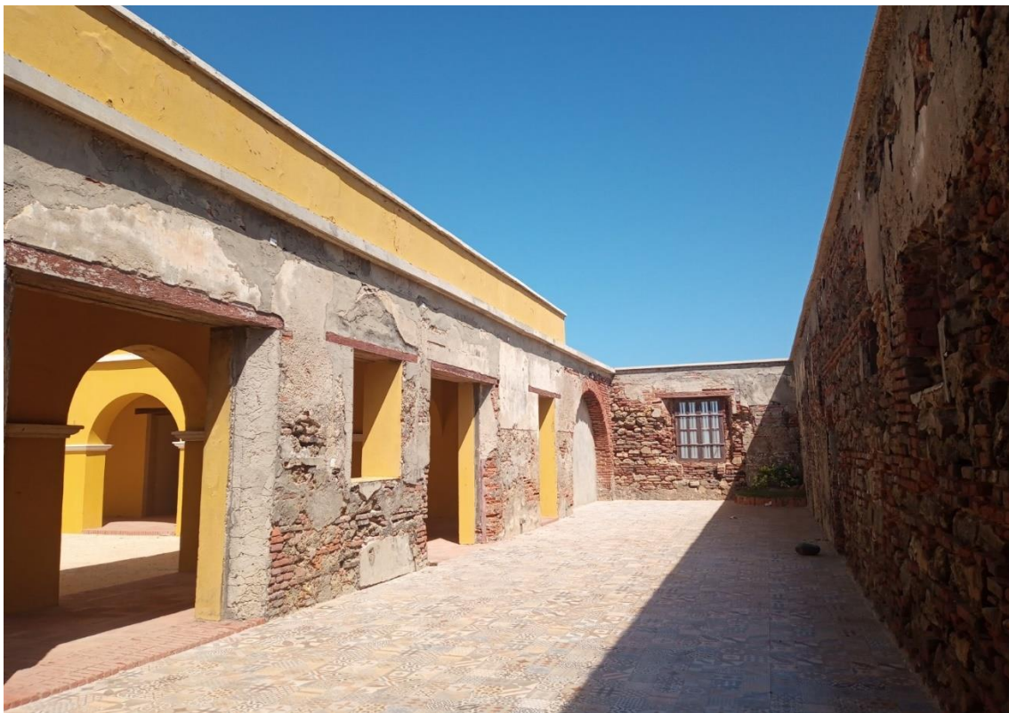
Imagen Propia – Patio trasero de la Edificación lado Sur.
