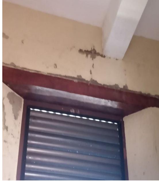
Imagen Propia – lesiones interiores por filtraciones de humedad en muros
