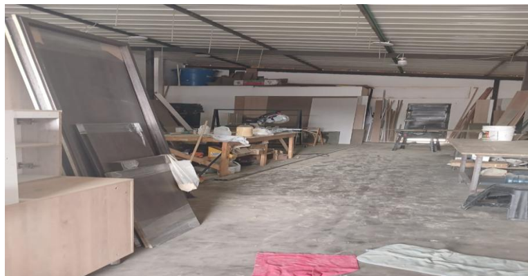
Figura 10 Estado inicial de la bodega.
