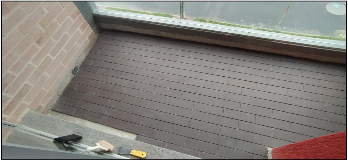
Ilustración 26 Balcón enchapado nuevo
