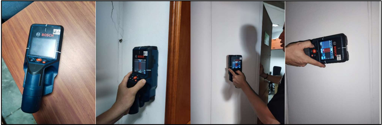
Figura 3. Ejecución del ensayo de Escáner de Refuerzo
