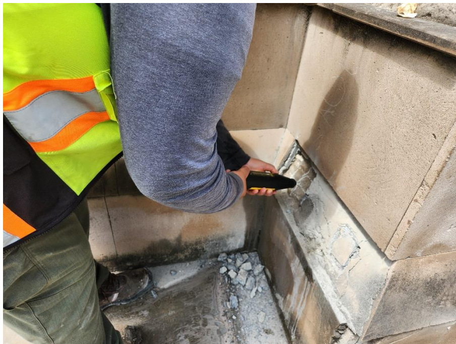
Ilustración 15. Evaluación del concreto por esclerómetro.
