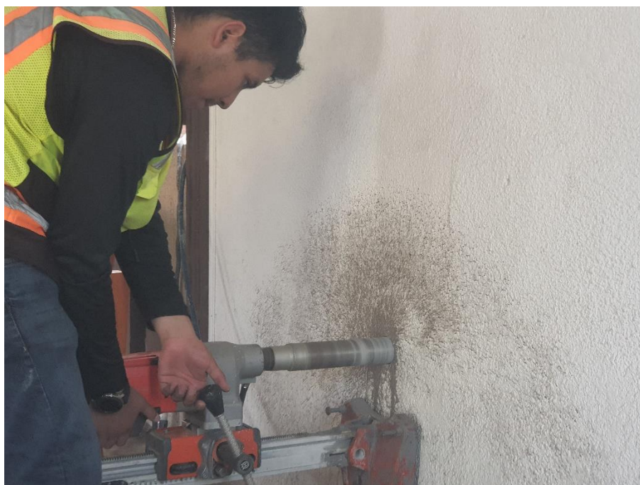
Ilustración 10. Extracción de núcleos en columna interna.
