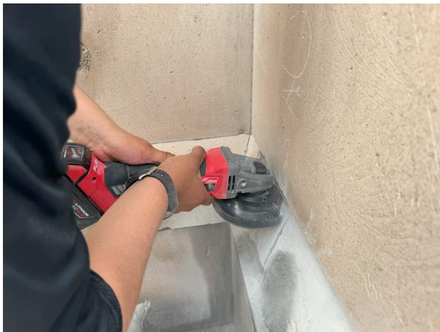
Ilustración 12. Corte de muro con maquina cortadora, para realizar prueba con esclerómetros.
