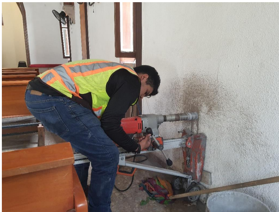
Ilustración 9. Extracción de núcleos en columna interna.
