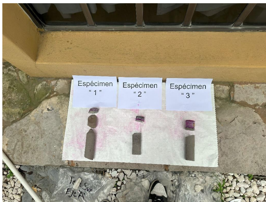
Ilustración 16. Prueba de indicador de carbonatación en concreto por medio de fenolftaleína.
