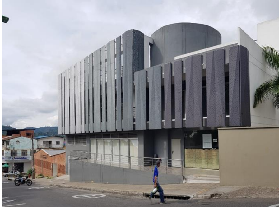
Figura 27. Fachada centro vida
