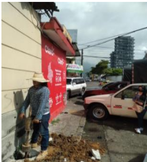
Imagen.7. (Ejecución extracción muestras de suelo)
