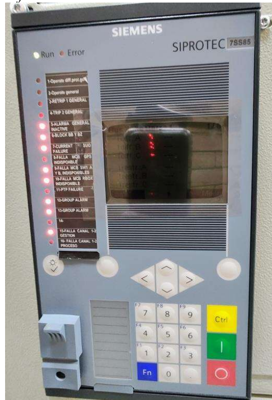
Figura 14. Relé con función 87B funcional.
