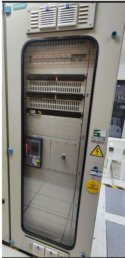
Figura 13. Relé integrado al SCADA de la Subestación.
