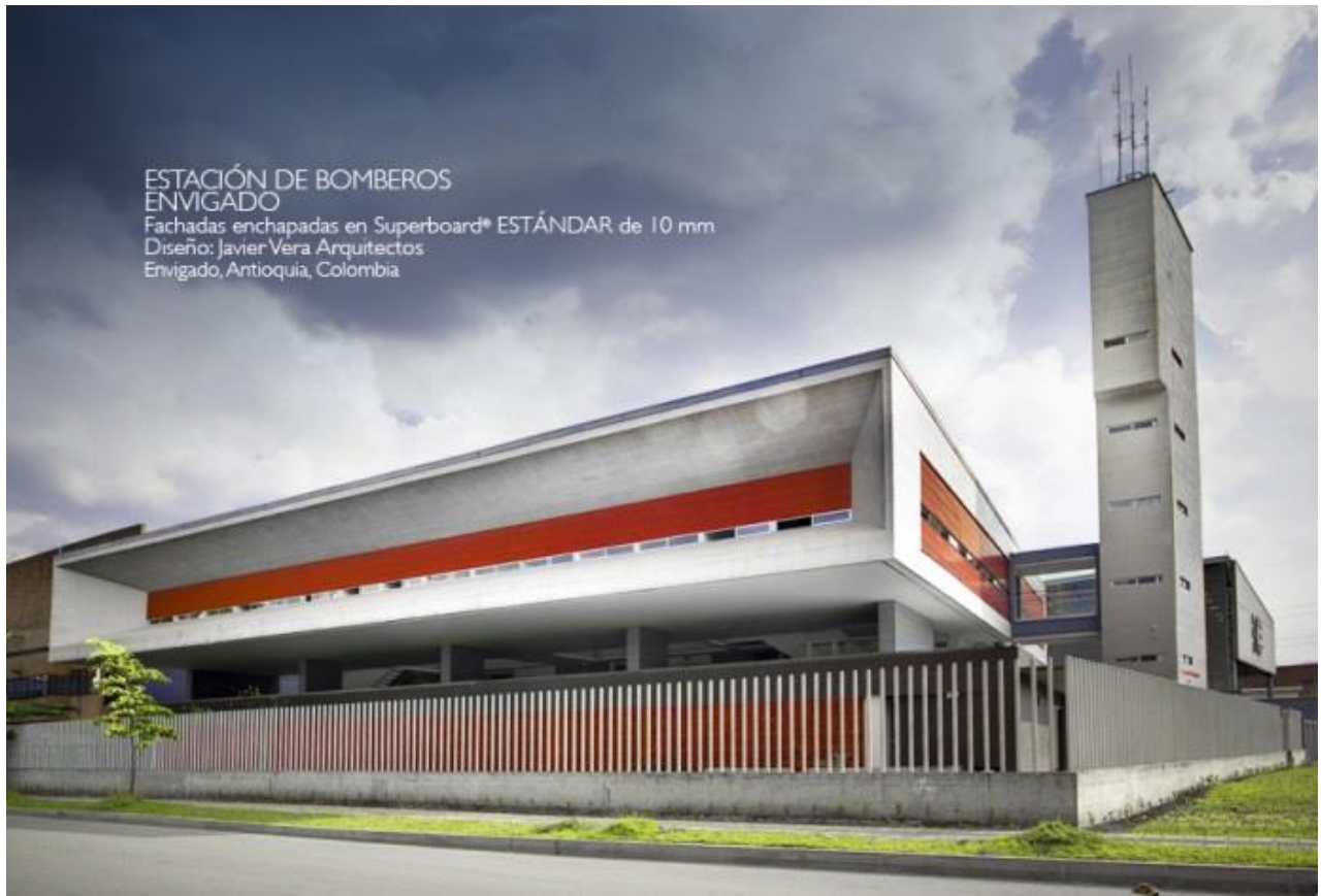
Figura 32. Estación bomberos envigado. Adaptado de
