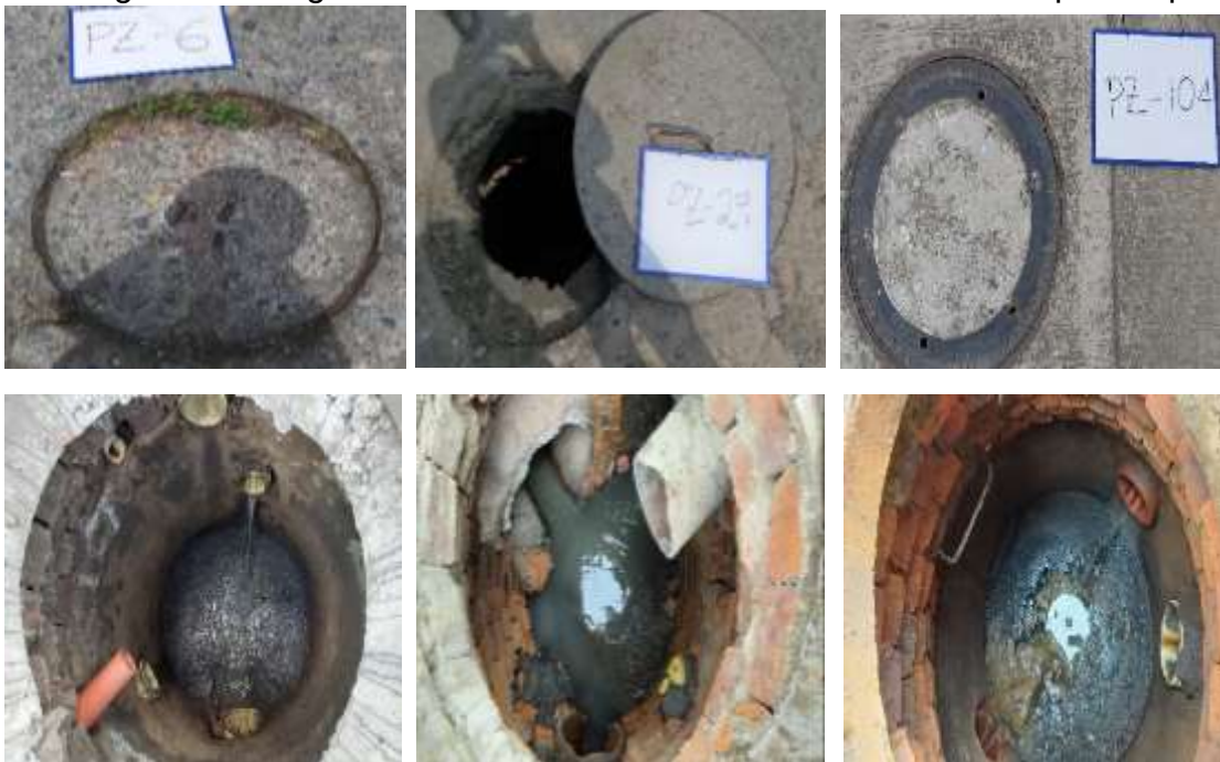
Fotografía 2. Diagnóstico sistema alcantarillado sanitario- municipio Quípama.
