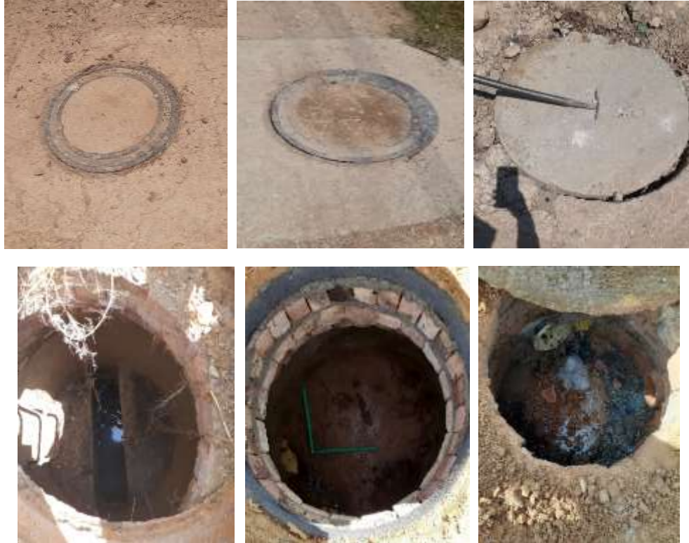
Fotografía 5. Registro fotografico del diagnóstico de alcantarillado.
