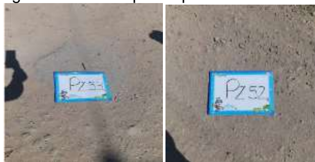
Fotografía 6. Pozos que no permiten su insección.
