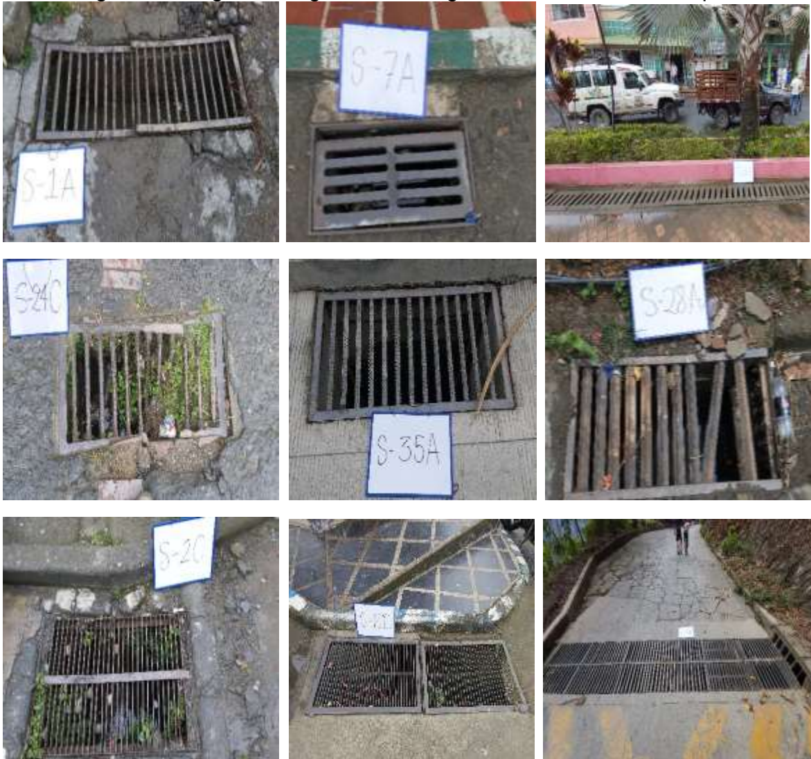
Fotografía 4. Registro fotografico del diagnóstico de alcantarillado pluvial.
