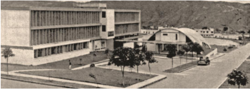
Figura 82. Fac. de Mecánica en Proa 157, oct. 1962, adaptado de adaptado de Ciudad-y-Arquitectura-Moderna-en-Colombia-1950-1970.pdf
