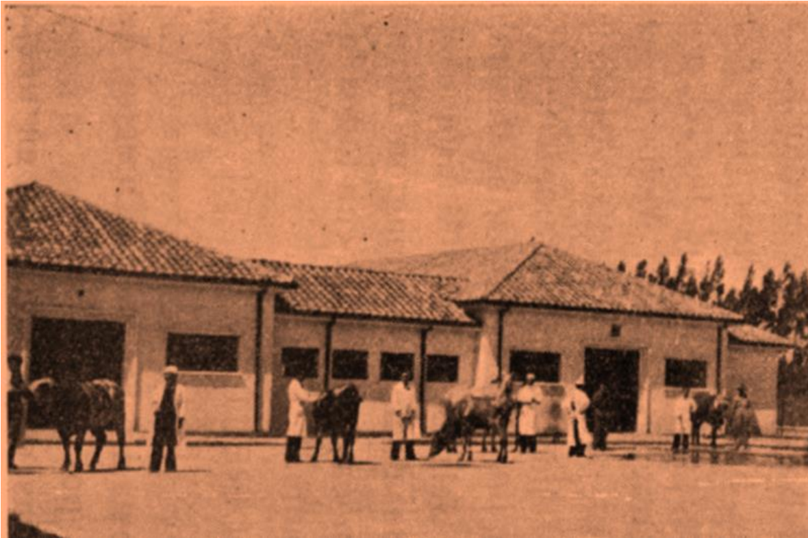
Figura 64 ,Vista Oeste Patio Central, adaptado de http://medicinaveterinariaydezootecnia.bogota.unal.edu.co/la-facultad/historia/linea-de-tiempo 1940
