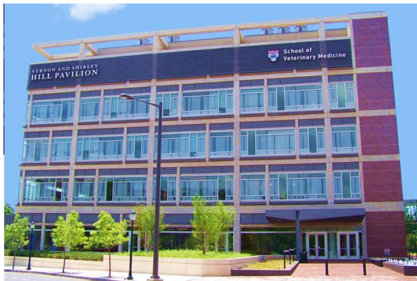
Figura 92. Escuela de Medicina veterinaria, PENN-EEUU adaptado de Fuente: http://www.turnerconstruction.com
