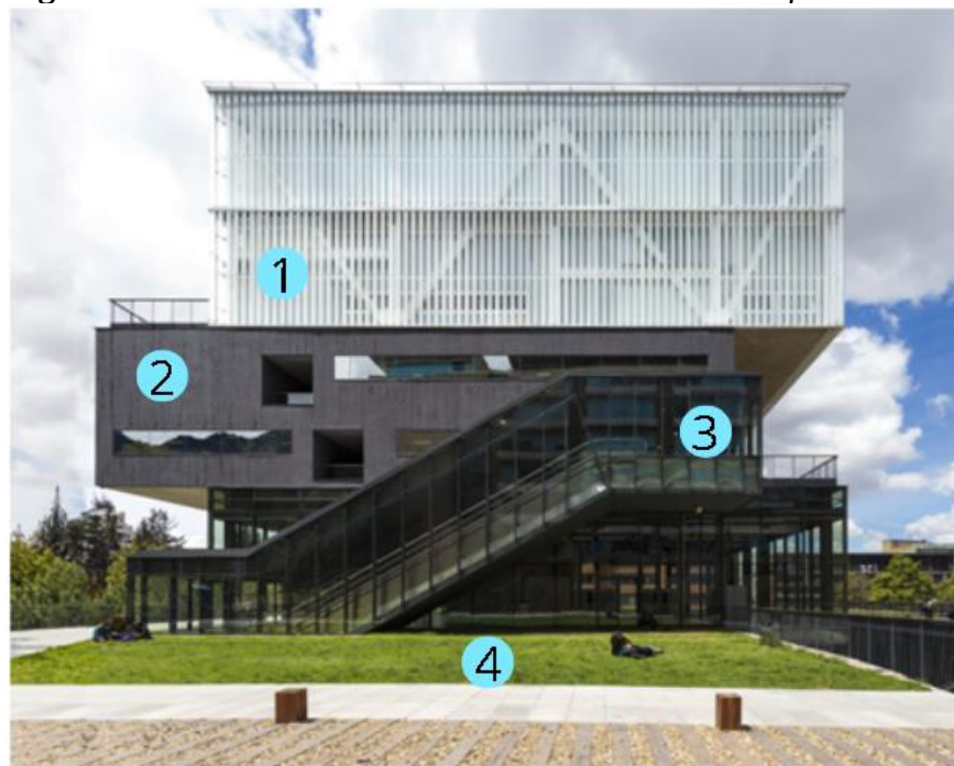
Figura 48. Características Constructivas- Fachada edificio Facultad de artes PUJ.
