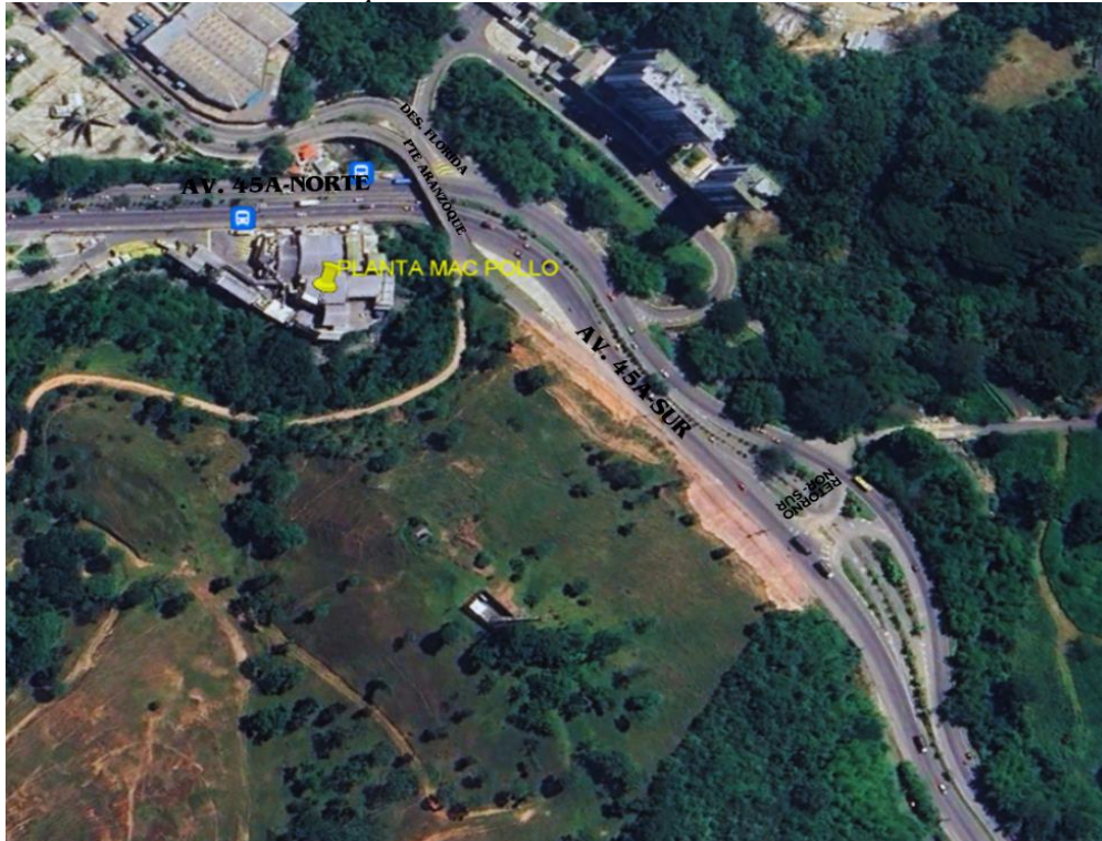
Figura 2. Sector 1. Puente Arangoque
