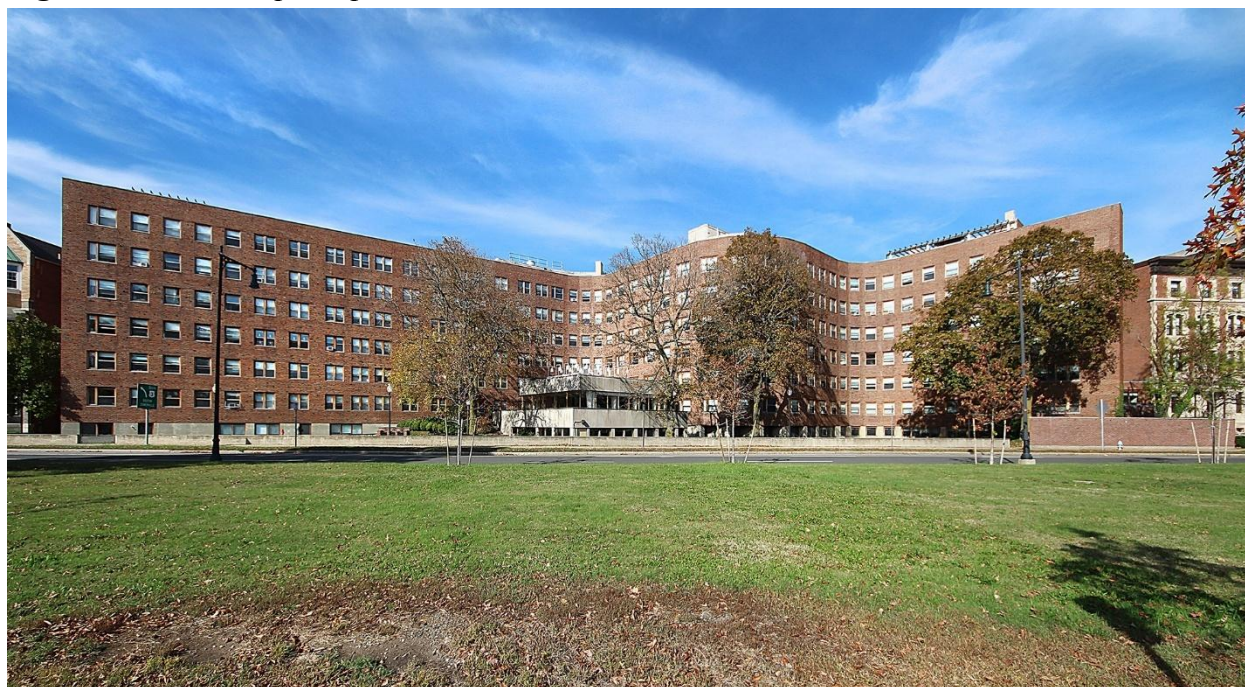
Figura 14. Fachada principal, Residencia Baker MIT. Estados Unidos
