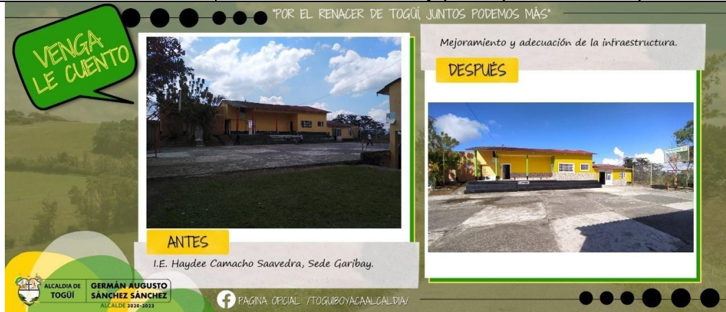
Imagen 39. Mejoramiento y adecuación infraestructura I.E. Sede Garibay.
