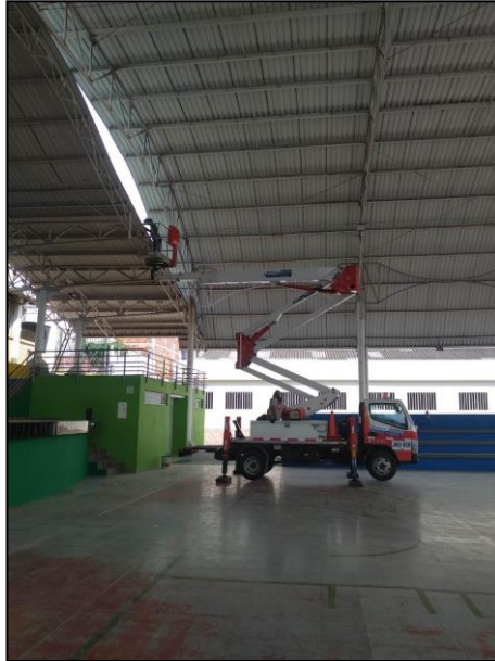
Imagen 18. Sellamiento de goteras, visita de supervisión polideportivo municipal. Fuente: Autor, 2022.
