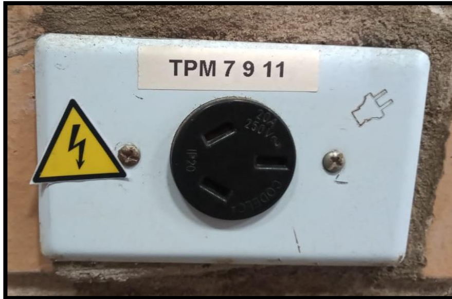
Figura 63. Toma Corriente 220V - 20A
