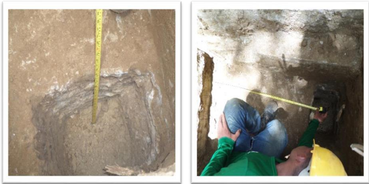
Figura 6. Fotografías Dimensiones Zapata 1. Tomada por el autor.
