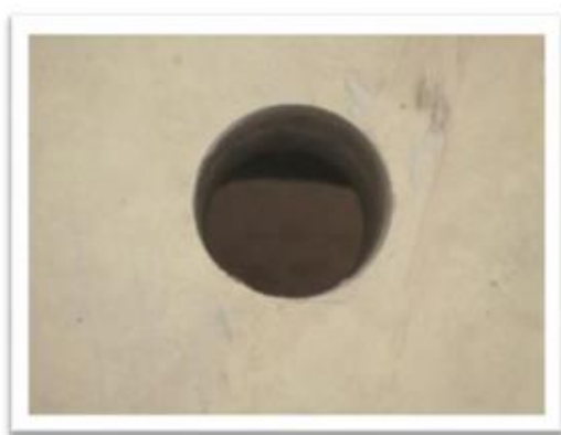
Figura 26. Exploración en las Losas de Todos los Niveles. Dimensiones Placa en el Tercer Piso. Tomada por el autor.
