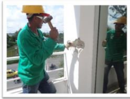
Escarigrafía columna tercer piso.
