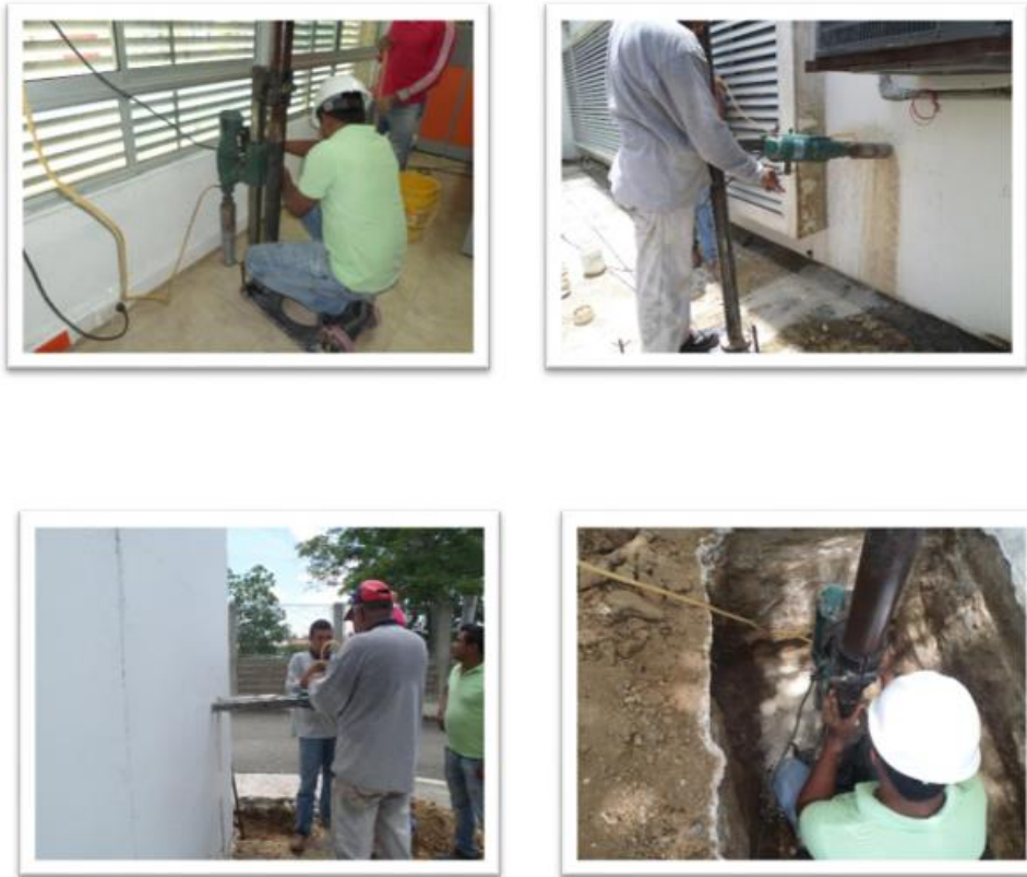
Figura 23. Extracción de Núcleos en Diferentes partes de la Estructura. Tomada por el autor.
