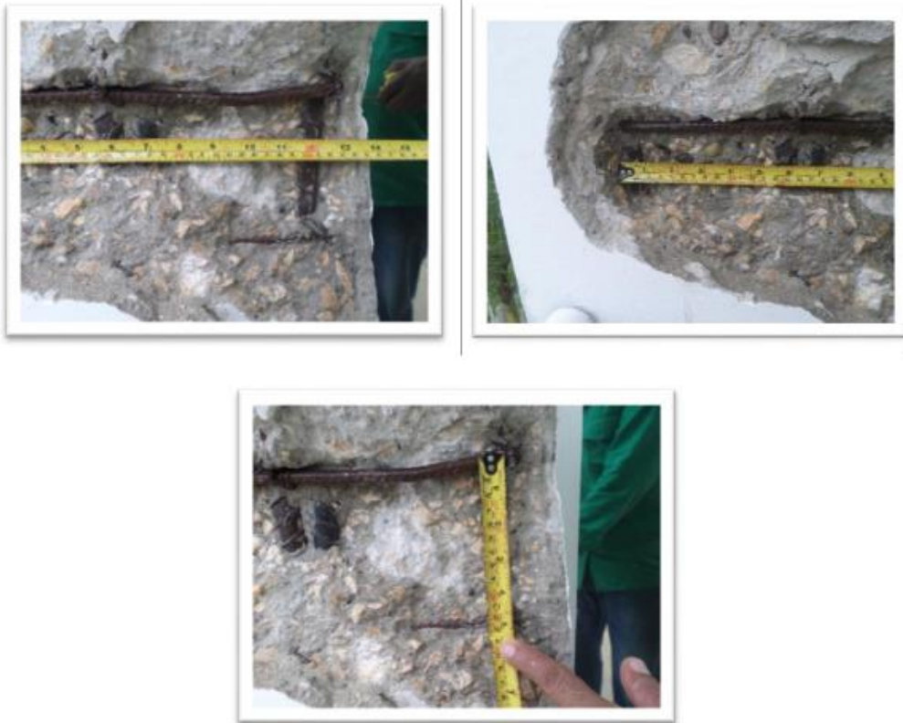
Figura 25. Exploraciones en la Estructura en los Tres Niveles. Exploración Columna de Tercer Piso y Separación Entre Barras, Columna 2 Tercer Piso. Tomada por el autor.
