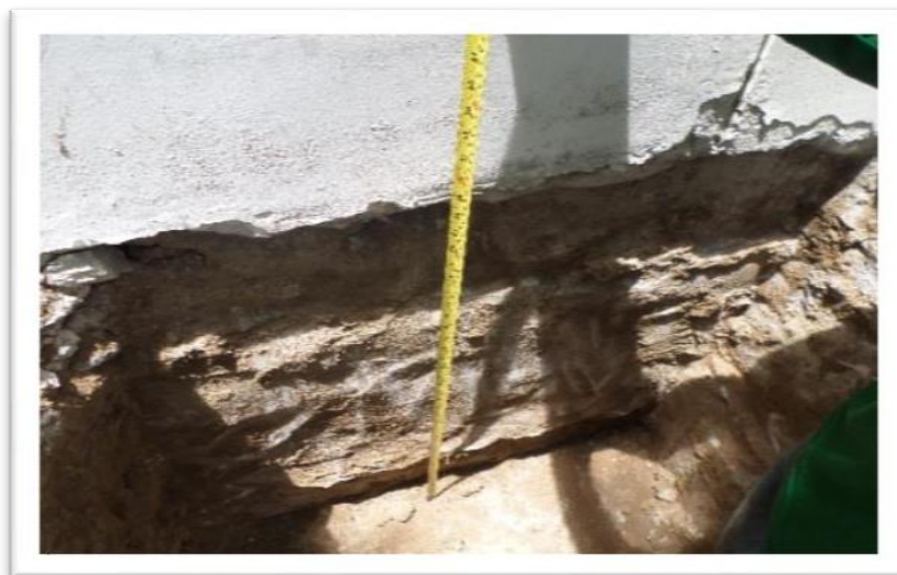
Figura 5. Exploración de cimentaciones. Tomada por el autor.
