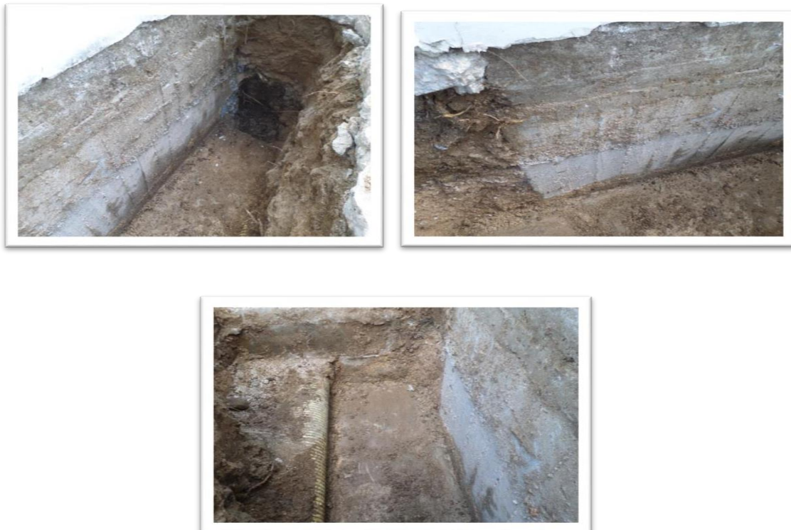
Figura 7. Exploración de muro y cimentación. Fuente: Tomada por el autor.
