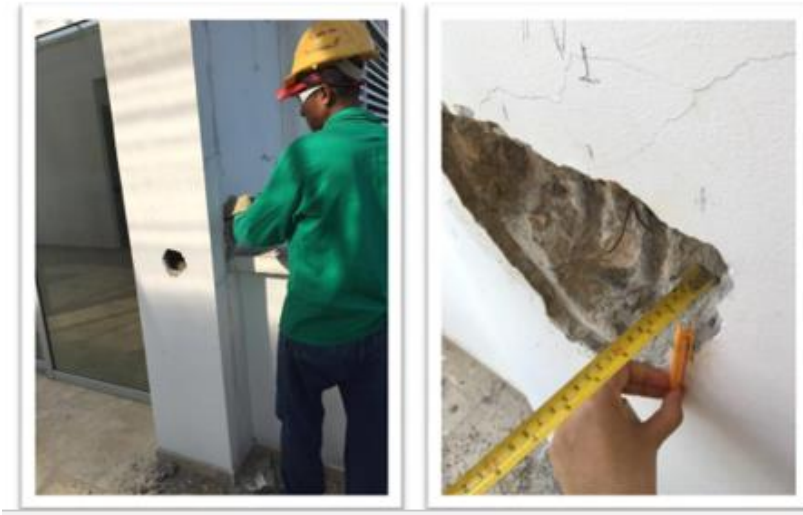
Figura 28. Exploraciones en la Estructura y Planta Arquitectónica Primer Nivel. Tomada por el autor.
