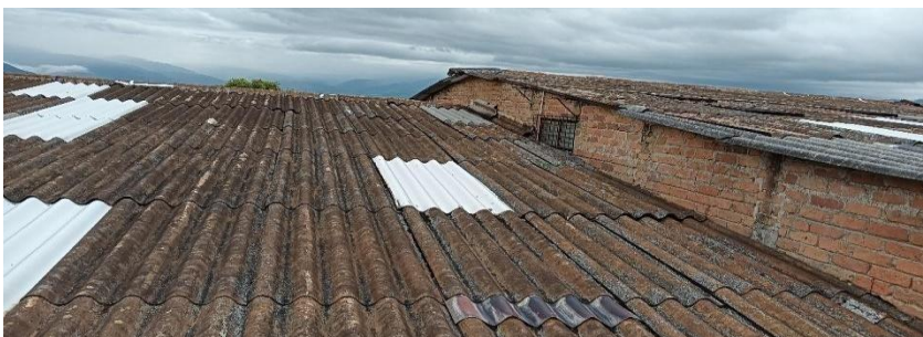
Ilustración 12 cubierta de asbesto cemento
