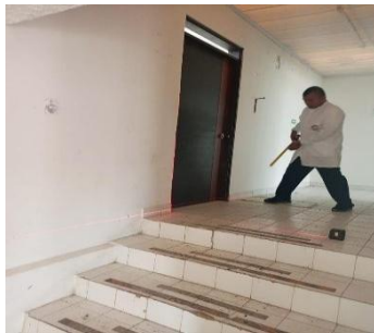
Ilustración 11 Revisión de verticalidad
