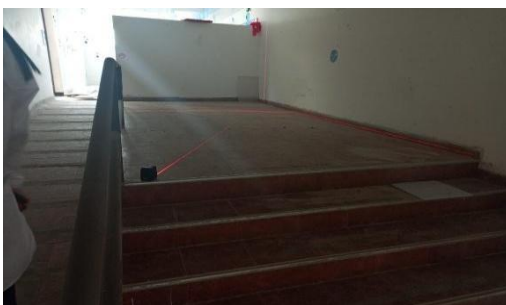
Ilustración 9 Verificación nivelación entrada
