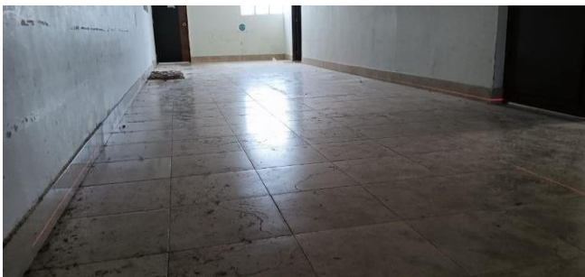
Ilustración 8 Verificación nivelación pasillo
