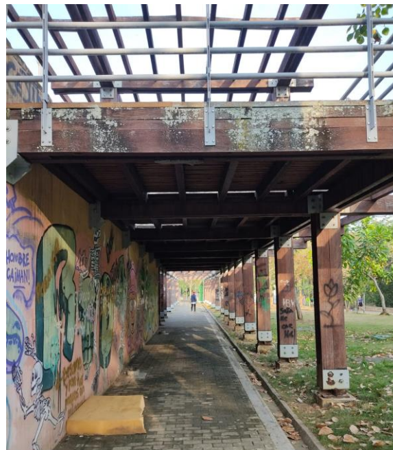
Figura 3. Muro de contención parte baja de la plataforma de presentaciones
