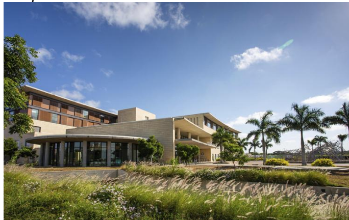
Figura 15. Proyecto de referencia 4 vista exterior.
