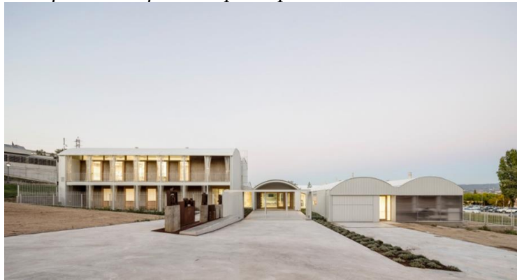
Figura 2. Proyecto de referencia 1 fachada principal
