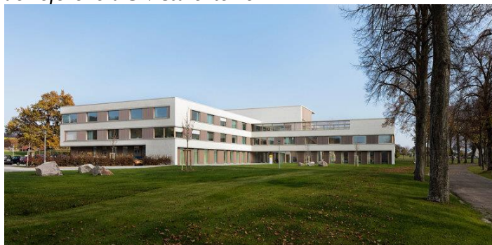
Figura 11. Proyecto de referencia 3 vista exterior
