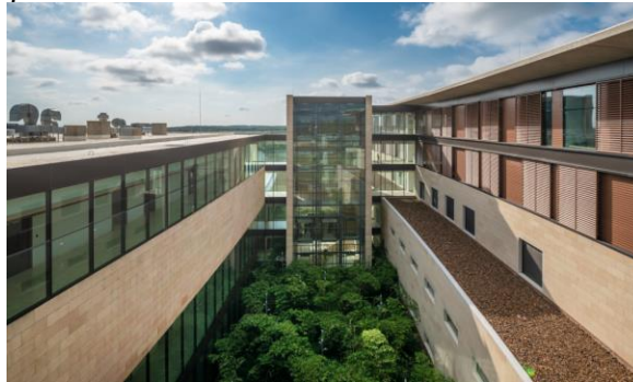
Figura 16. Proyecto de referencia 4 vista exterior
