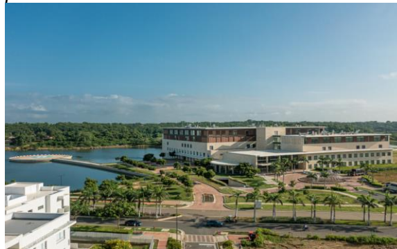
Figura 17. Proyecto de referencia 4 vista exterior.
