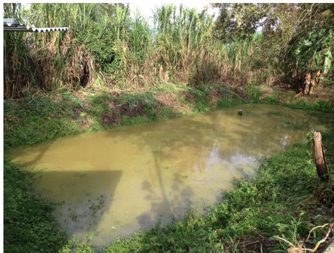
Imagen 10. Laguna de oxidación
