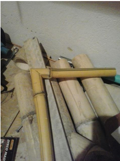
Figura 7. Unión de bambú en ángulo
