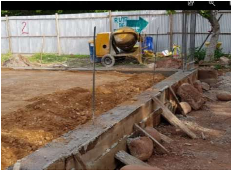
imagen 38 Fundida de viga de cimentación
