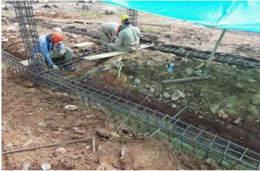
imagen 6. Armado de cimentación
