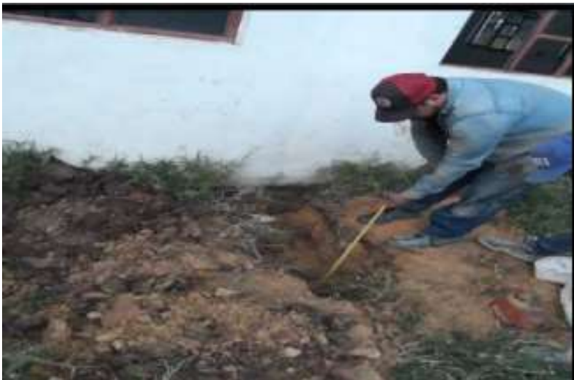
imagen 10. Excavacion calicata
