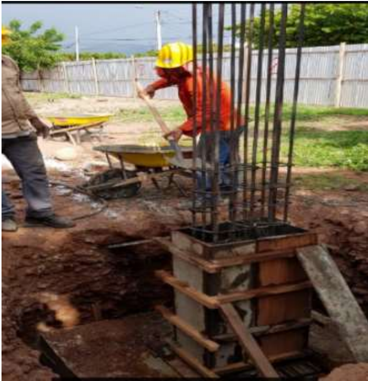
imagen 34. Fundida de zapata
