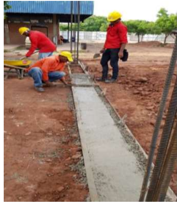
imagen 39 Fundida de viga de cimentación
