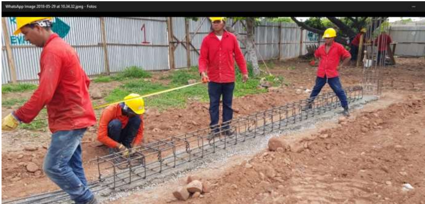
imagen 37 Armado de acero de refuerzo
