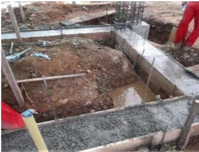
imagen 7. Fundida de cimentación
