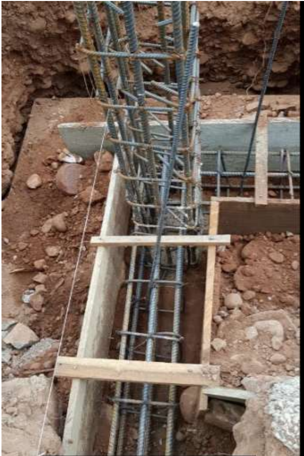
imagen 35 Encofrado y fundida de viga de cimentación
