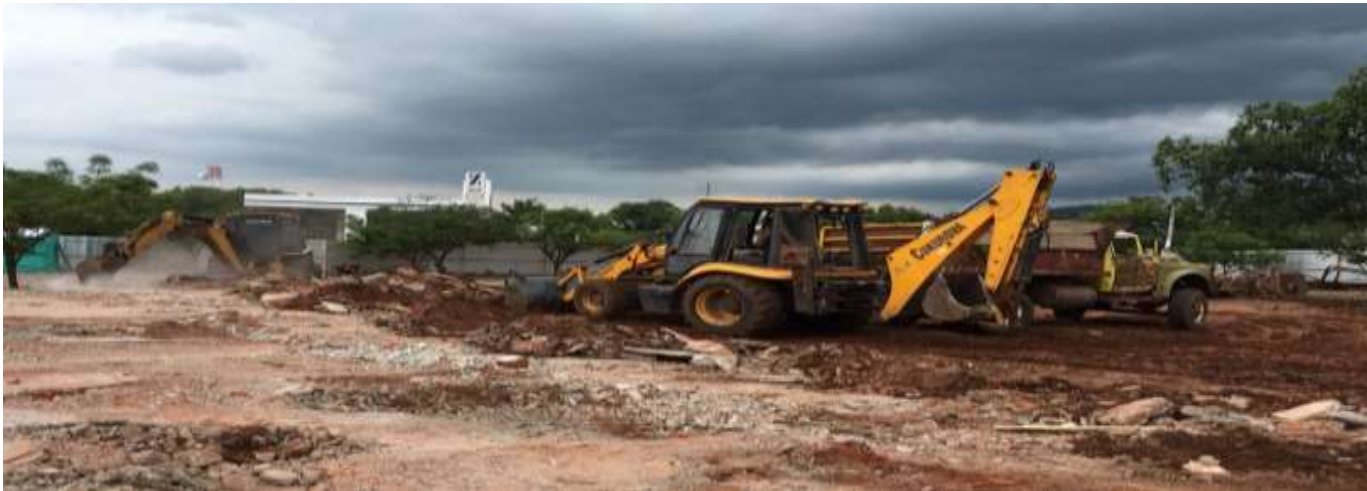
imagen 28 Demolicion de plaza de mercado
