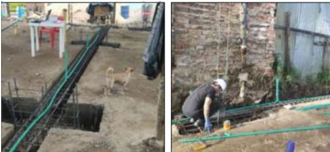
imagen 8.Construccion de zapatas y vigas de cimentación
