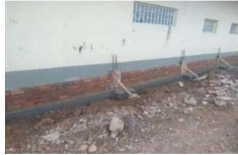
imagen 3.construcción de cimentación.
