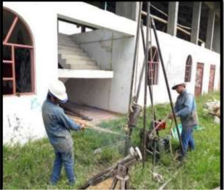
imagen 9. Perforación método SPT
