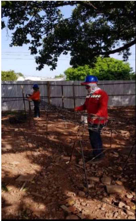
imagen 33 Armado de acero de cimentación
