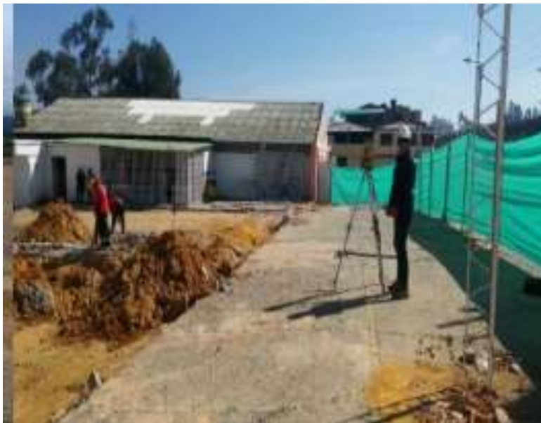
imagen 4.Control de niveles cimentación
