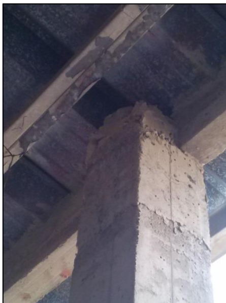
Ilustración 11. Unión viga - columna
