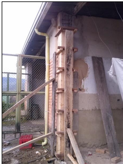
Ilustración 10. Encofrado de columnas
