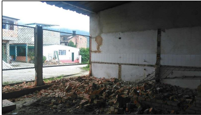
Ilustración 3. Demolición de estructuras en concreto y mampostería.
