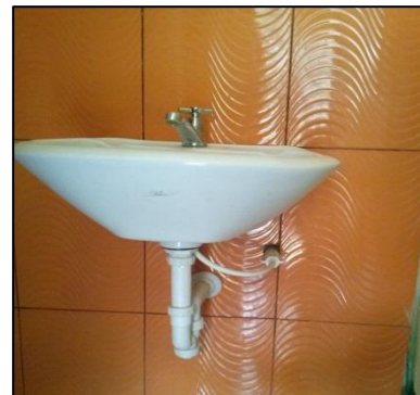
Ilustración 17. Mejoramiento de instalación hidráulica
