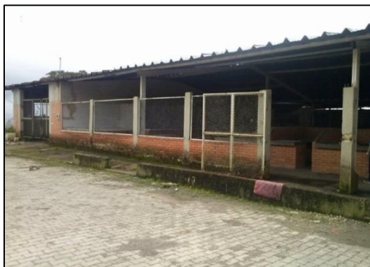
Ilustración 2. Instalación antigua - Plaza de Mercado
