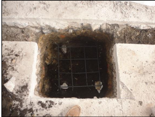
Ilustración 6. Refuerzo en zapatas.
