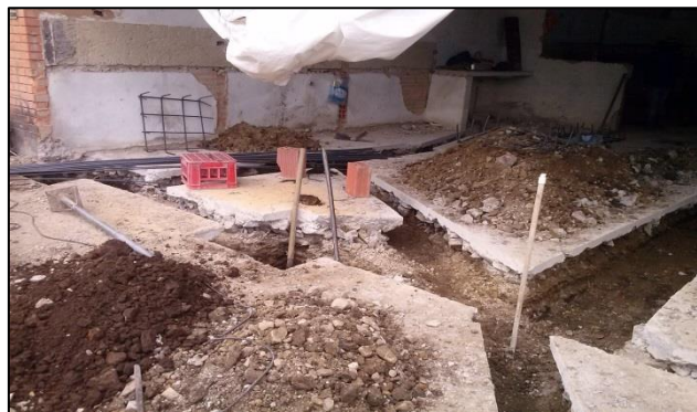
Ilustración 4. Excavación de placa de concreto.
