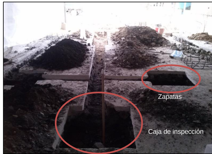
Ilustración 5. Vista general de cimentación
