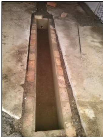
Ilustración 7. Sumidero en mampostería
