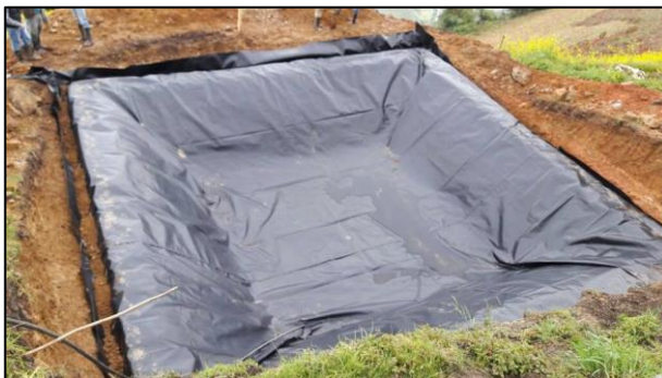
Ilustración 33. Reservorio en construcción
