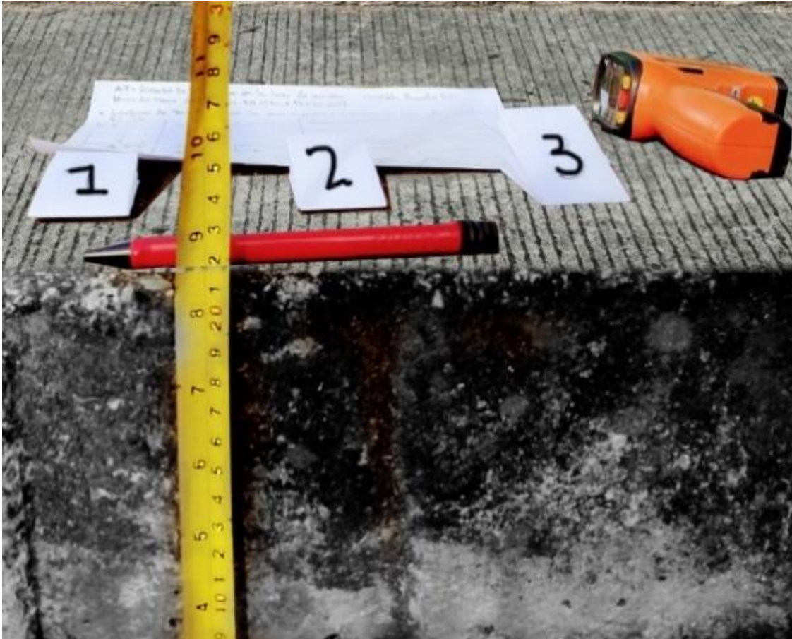
Figura 13. Losa 20 cm, espesor.
