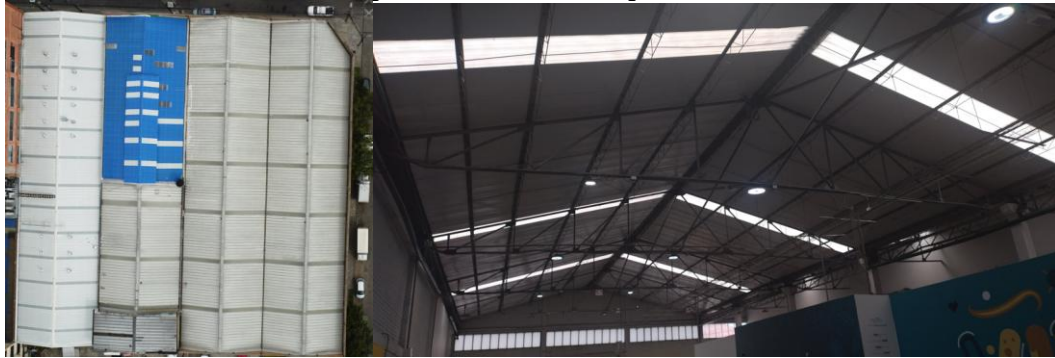
Figura 9. Revisión estructural cubierta para instalación en planta Totto
