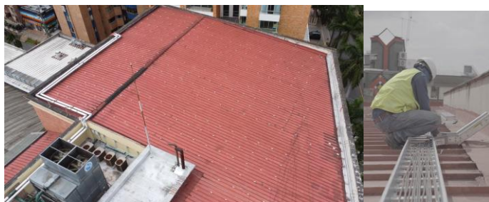
Figura 5. Instalación de anclajes y rieles
