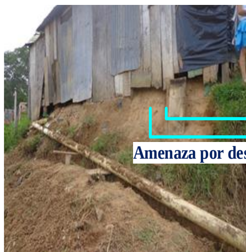
Ilustración 14. Deslizamiento zona de expansión SE2 y amenaza por deslizamiento. Fuente: Propia
