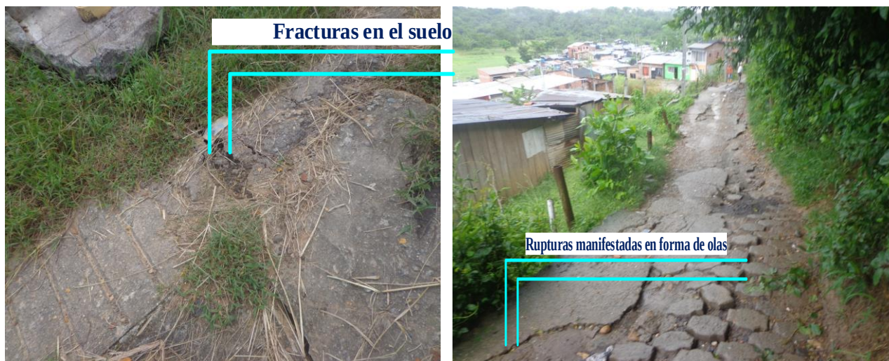
Ilustración 15. Fracturas en el suelo en improvisados caminos de la zona de expansión SE2. Fuente: Propia
