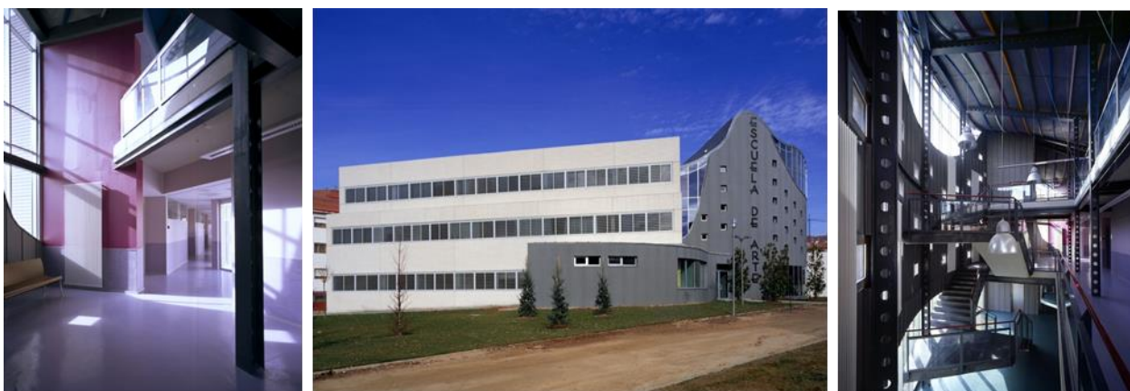
Figura 15. Interior y exterior de la escuela de artes de Guadalajara, España
