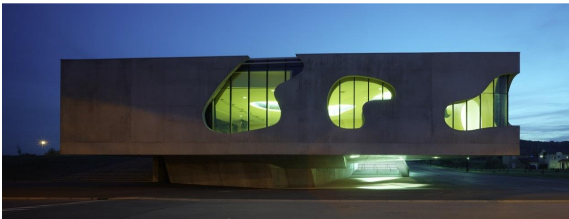
Figura 7. Fachada principal del conservatorio de la música en Maizières, Francia.
