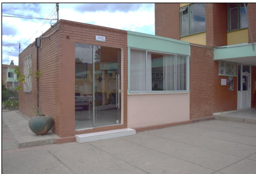
Ilustración 7: Fachada exterior de la Rectoría de la Normal de Chiquinquirá. Fuente: El autor (2017)
