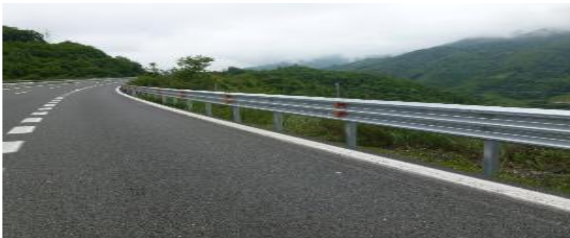
Figura 33. Defensas viales metálicas
