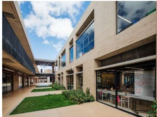
Figura 22. Exterior – Fachada salones y relación espacial interna
