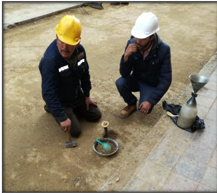
Imagen 9. Toma de muestras para ensayos de laboratorio en la calle 25 entre carreras 8 y 9. Ensayo cono de arena.
