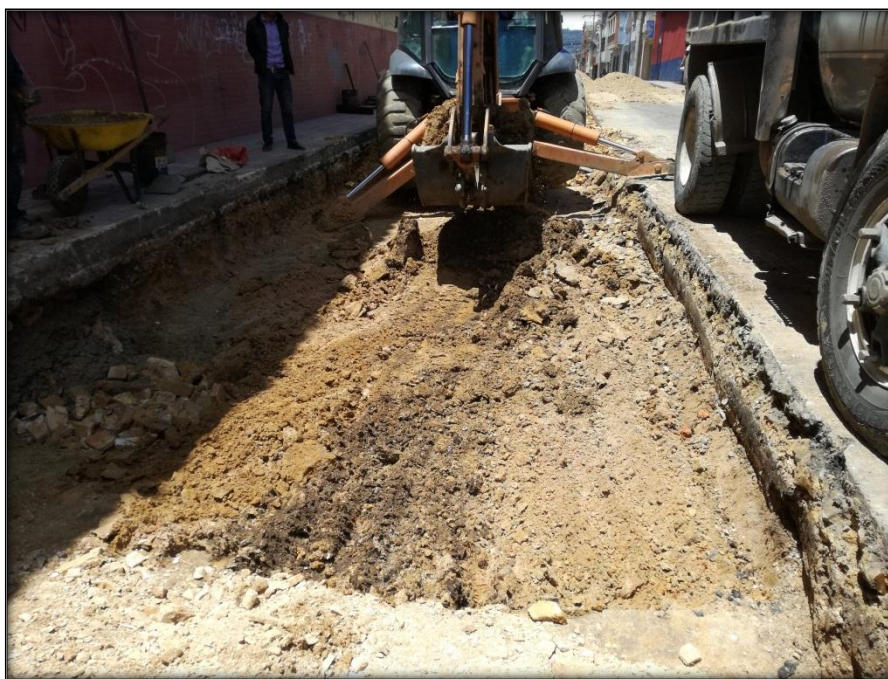
Imagen 5. Excavación de las cajas
