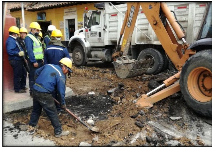
Imagen 19. Trabajadores con implementos de seguridad
