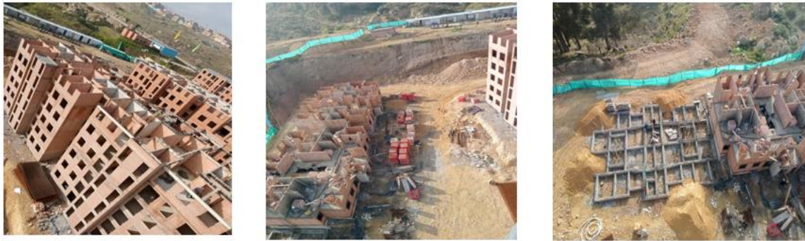
Figura 5 Vista general construcción de torres
