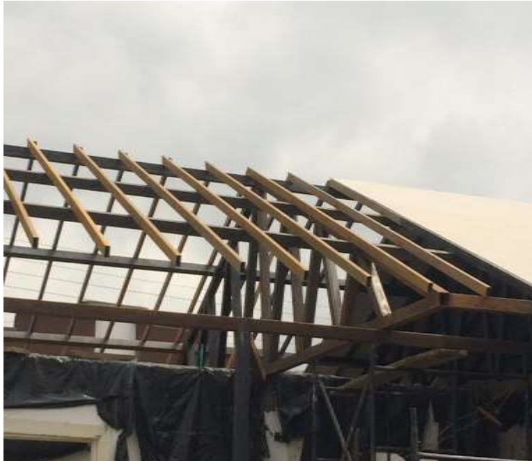
Ilustración 8 . Intervención cubierta de la casa Eduard Paulus. Restauración de vigas aéreas en madera, soporte en estructura metálica y cielo raso en panel yeso.
