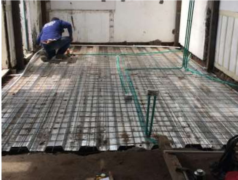
Ilustración 6 . Intervención del piso de madera de la casa Eduard Paulus. Losa de contrapiso en concreto reforzado con malla electrosoldada.
