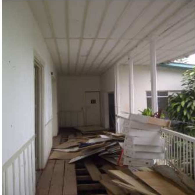
Ilustración 13 Corredor al interior de la casa Eduard Paulus. Piso en madera y cubierta sin intervenir.
