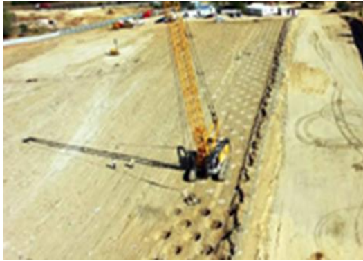
Figura 16. Compactación dinámica (vyepe 2012).
