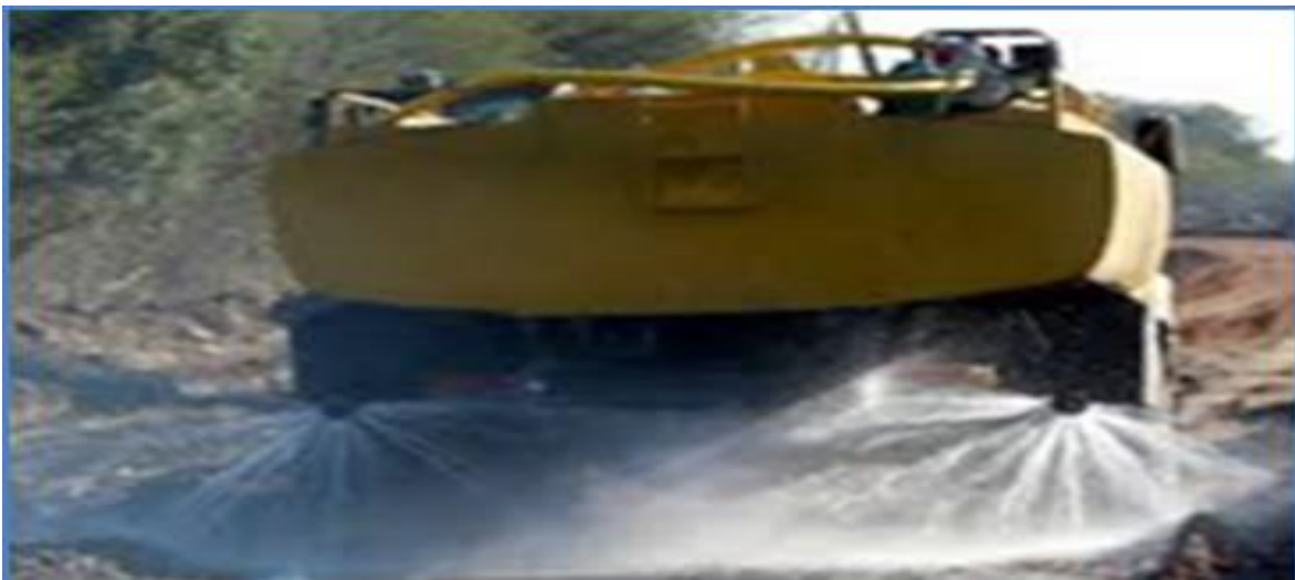
Figura 2. Mezcla con químicos (vía rural 2012).
