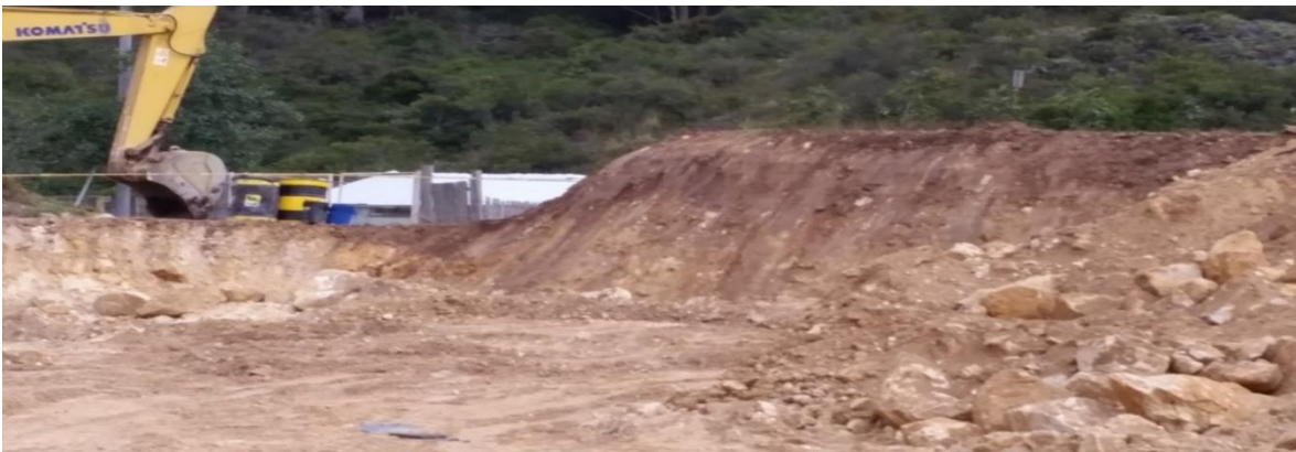
Figura 91.Movimiento de tierra para la preparación del sitio y la efectucción del ensayo piloto con las detonaciones.
