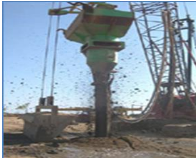
Figura 10. equipo para vibroflotacion smms 2009.
