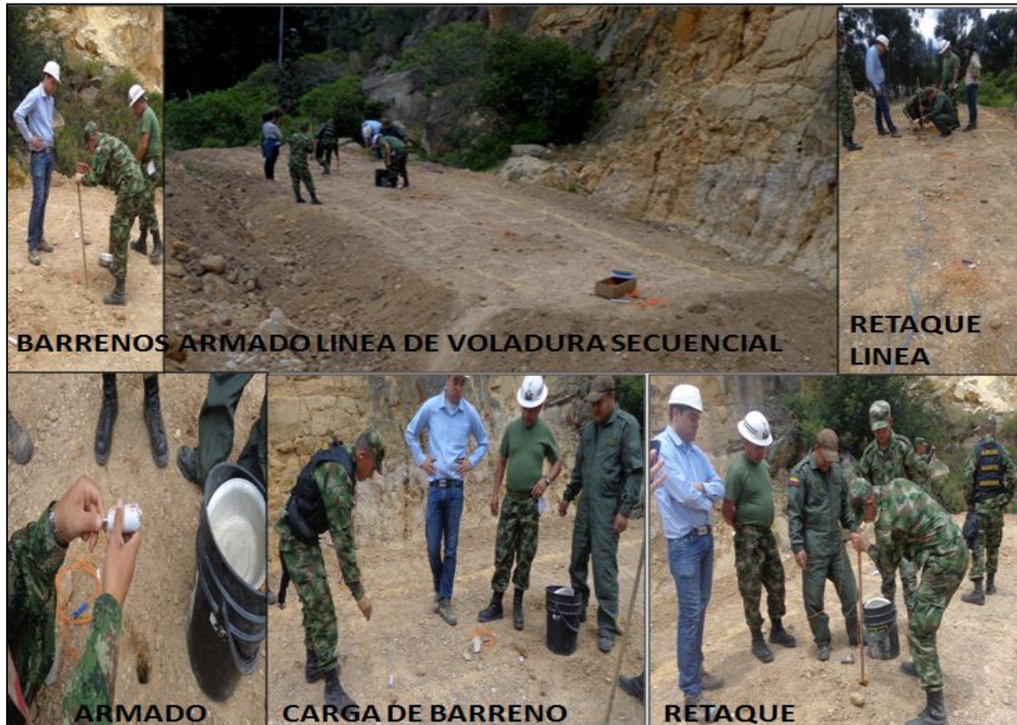
Figura 124. Proceso constructivo para el armado del sistema de voladura
