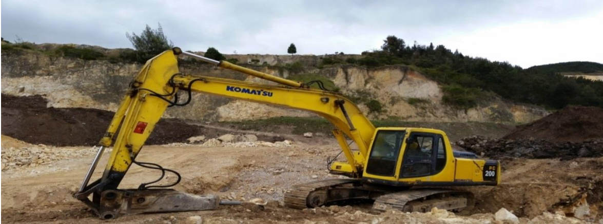
Figura 96. Retroexcavadora 220, equipo utilizado para la realización del corte y los apiques. Fuente: Elaboración Propia.
