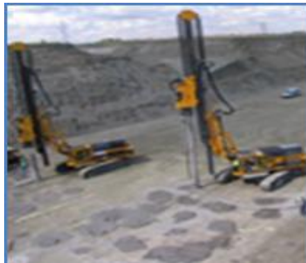
Figura 14. Equipo para inclusiones rígidas 2009.
