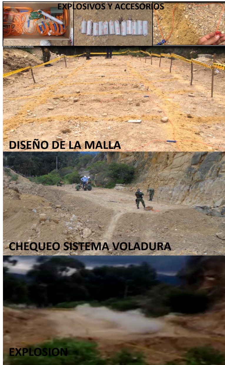
Figura 126. Verificación y Detonación Final.
