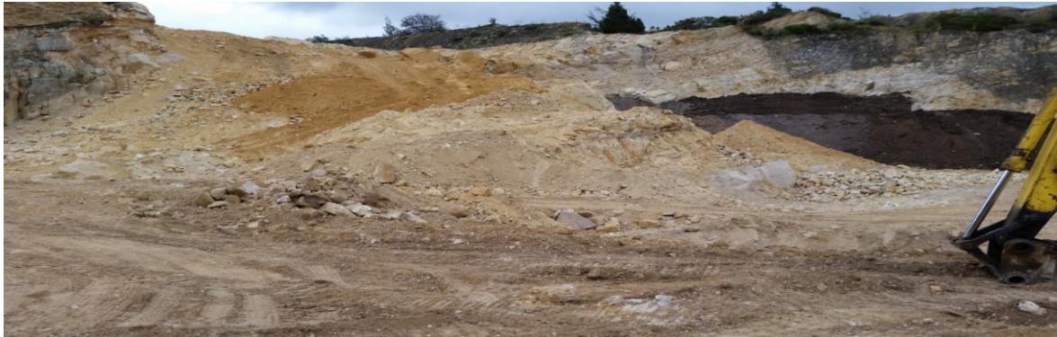
Figura 102. Diferentes acopios de material para base y subbase granular.
