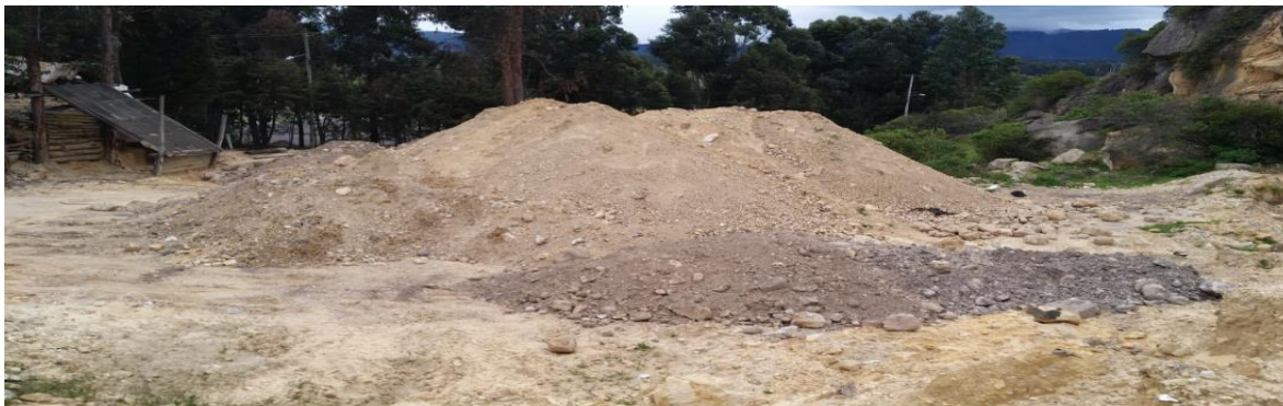
¡Error! No se encuentra el origen de la referencia. Figura 101. Acopio de material granular para construcción de carreteras.
