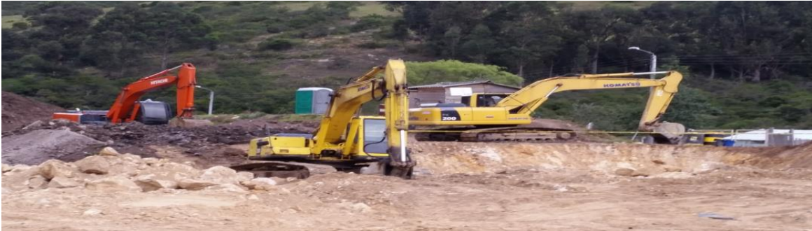
Figura 90.Implementación de Maquinaria en este caso retroexcavadoras para la elaboración de los cortes para el ensayo piloto en la cantera.
