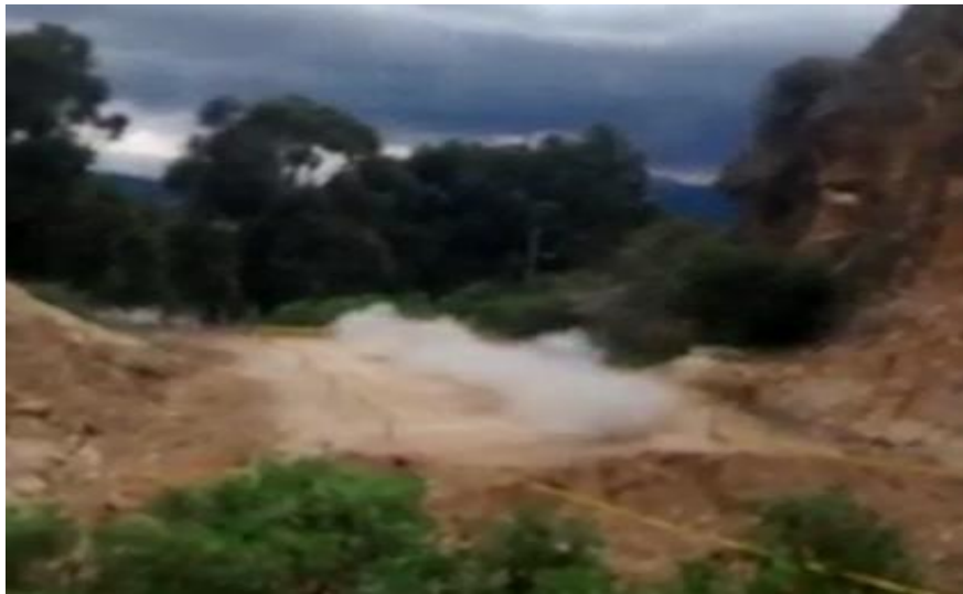
Figura 52. Uso de explosivos.
