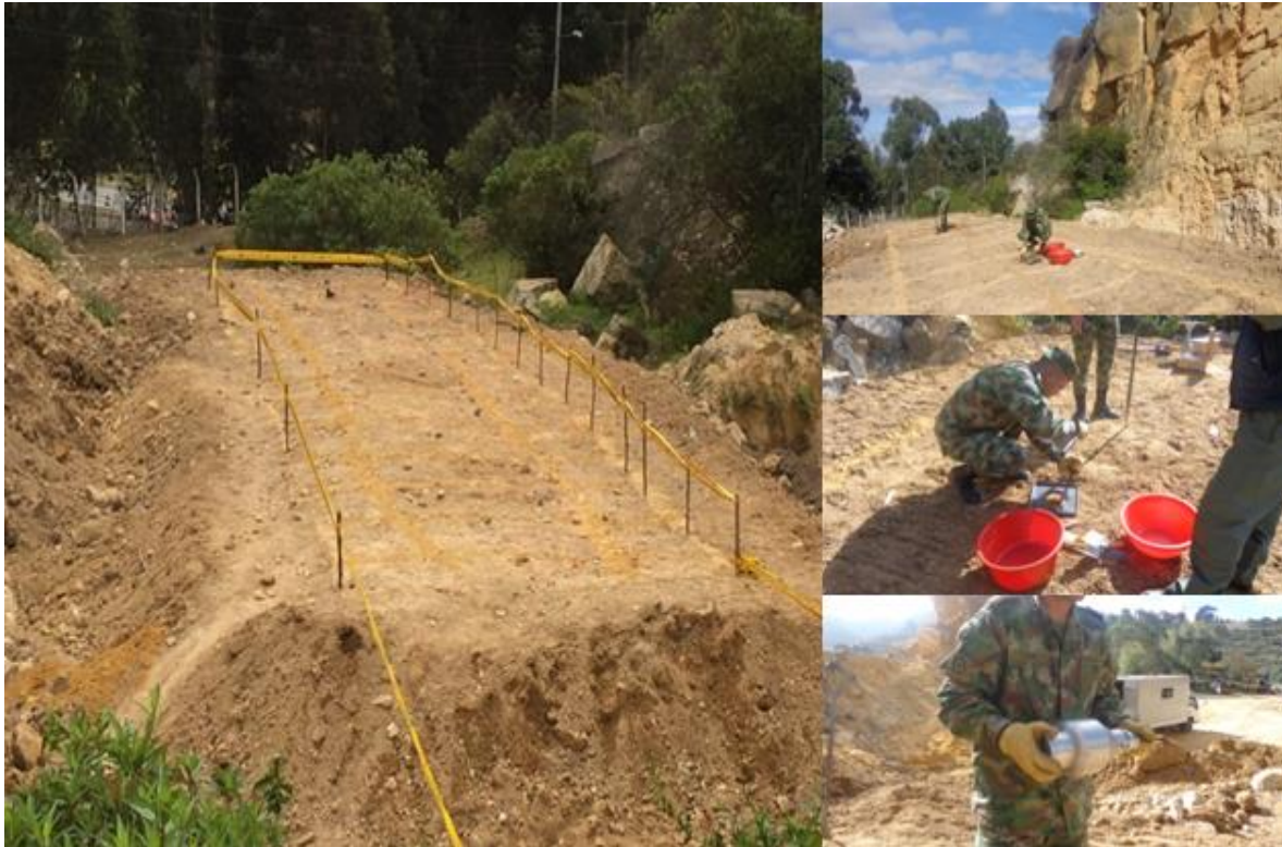
Figura 104. Densidades del terraplén conformado.
