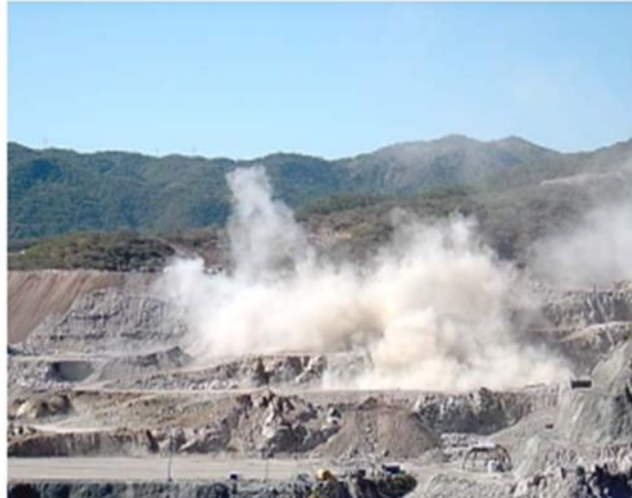
Figura 53. Uso de explosivos en lugares aislados.
