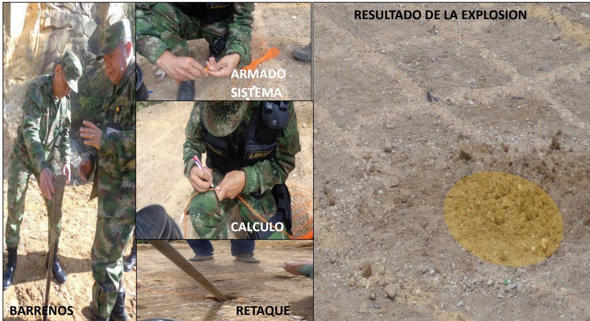
Figura 111. secuencia proceso detonación Prueba 2
