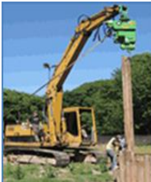
Figura 12. Equipo de vibrohincado smms 2009.
