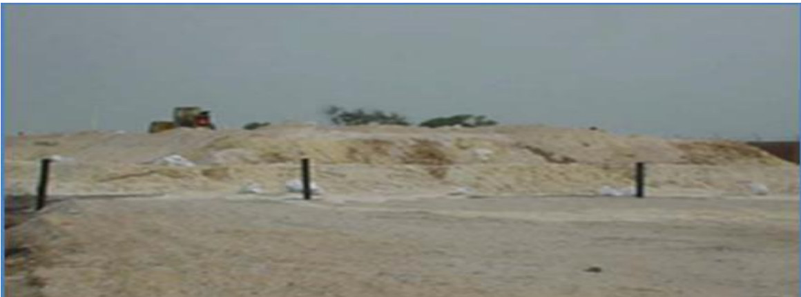
Figura 6. Sistema de precarga (ucm 1990).
